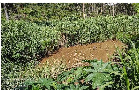
Foto 5: Bacia de sedimentação no final do Canal Central de escoamento de água pluvial.
