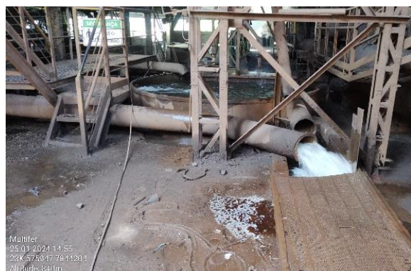
Foto 4: Água quente saindo da caixa na base do alto-forno sendo despejada na canaleta que conduzirá a água para fora da área operacional.
