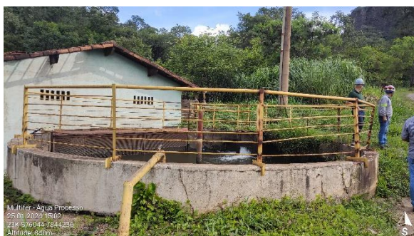
Foto 17: Tanque de resfriamento de água do alto-forno.
