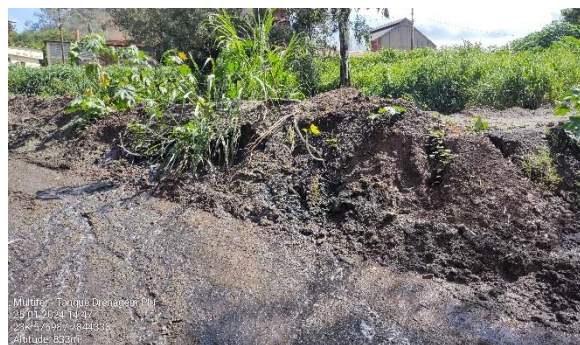
Foto 10: Aterro da bacia de sedimentação de efluente com grafite apresentando extravasamento no talude devido ao assoreamento e consequente entupimento da tubulação.
