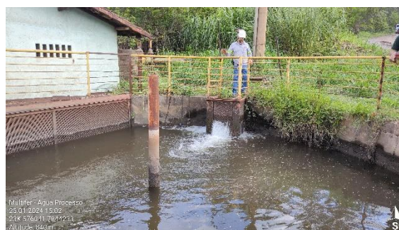
Foto 18: Detalha da água de resfriamento do alto-forno e ao fundo da foto pode ser verificada tubulação que leva a água do processo para os tanques de acumulação e retorno para o alto-forno.
