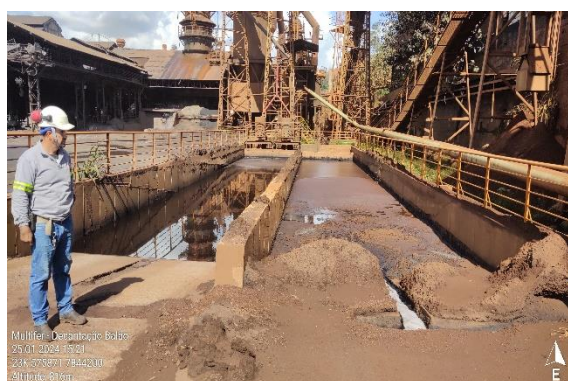
Foto 15: Tanque de decantação de água proveniente do lavador de gás e do desumidificador.
