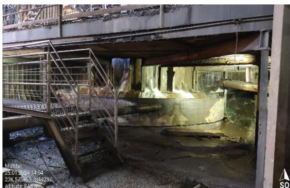
Foto 3: Estrutura de captação da água de resfriamento no alto-forno, onde está ocorrendo extravasamento.
