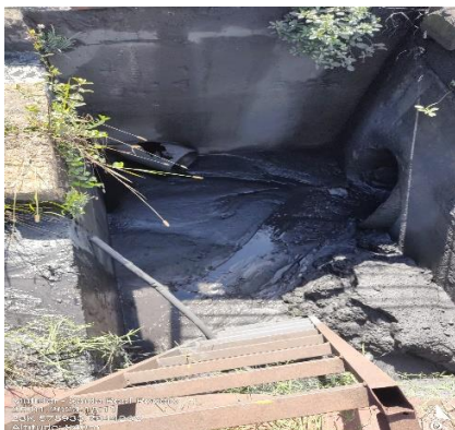
Foto 7: Efluente com grafite, proveniente do rodeo canalizado.
