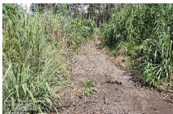
Foto 6: Sedimento arrastado pela água de chuva e lançado na bacia de sedimentação.
