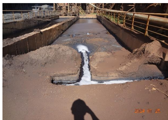
Foto 16: Detalhe do tanque, com a canaleta que recebe a água com pó de balão que é bombeada do lavador de gás e do desumidificador.
