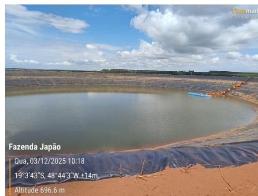
Foto 02. Vista reservatório Off Stream
