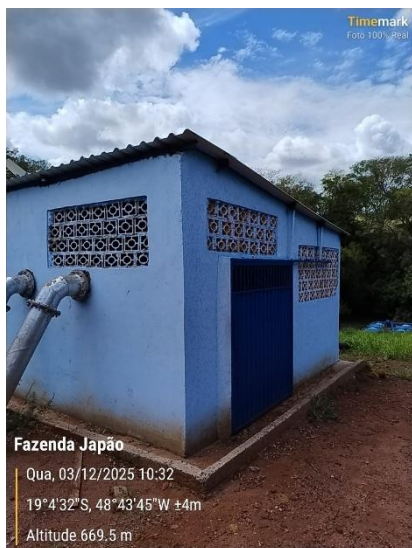
Foto 03. Vista ponto de captação superficial
