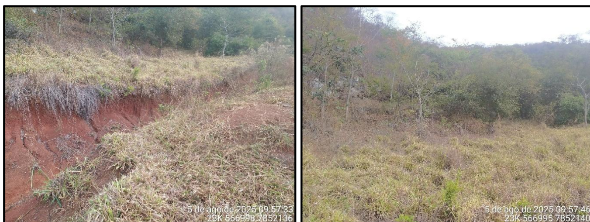
Figura 8: Vista da área 03 de recuperação. Fonte: Canastra Ambiental, 2025.
