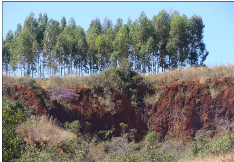
Foto 12. Camada de carapaça com cerca de 10 m de espessura que cobre o topo da chapada a sudeste da mina da Ultracal – área das nascentes do ribeirão Andrade.
