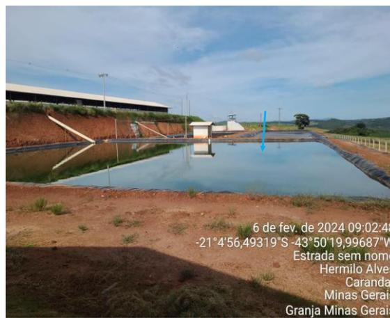
Foto 04. Lagoa de armazenamento de água pluvial.
