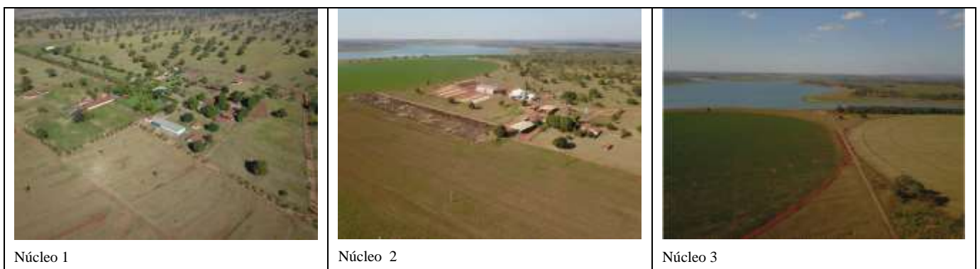
Figura 3 - Estruturas existentes dentro da Fazenda São Joaquim. Fonte: Totus Ambiental, 2023.
