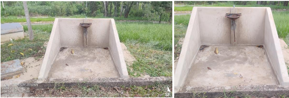
Área para lavagem de veículos, sistema com canaletas e CSAO;
