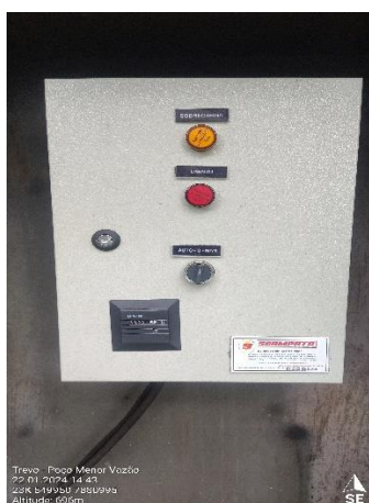
Foto 13: Pannel de controle da bomba com horímetro do poço de menor vazão.
