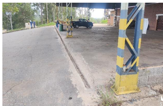
Foto 6: Canaleta coletora da oficina. Ao fundo da foto, verifica-se o final da canaleta que desagua na CSAO.
