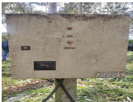
Foto 11: Pannel da bomba com horímetro do poço de maior vazão.
