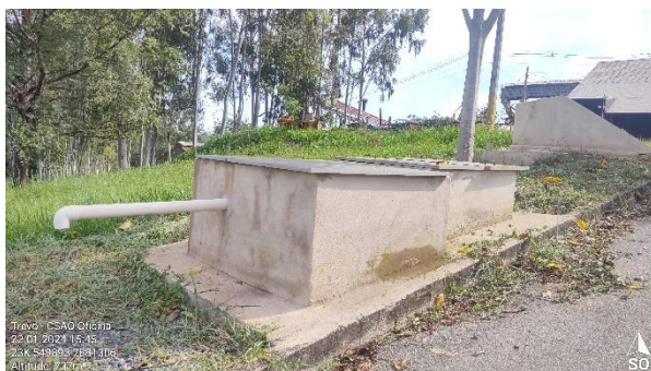
Foto 7: CSAO da oficina. Desagua efluente em sistema de sumidouro. Mas não está em uso.
