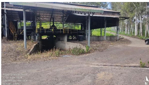
Foto 9: Canaleta coletora de água pluvial interceptando o acesso e direcionando o efluente para a bacia de sedimentação.
