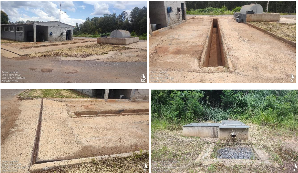
Área para lavagem de veículos, sistema com canaletas e CSAO;
