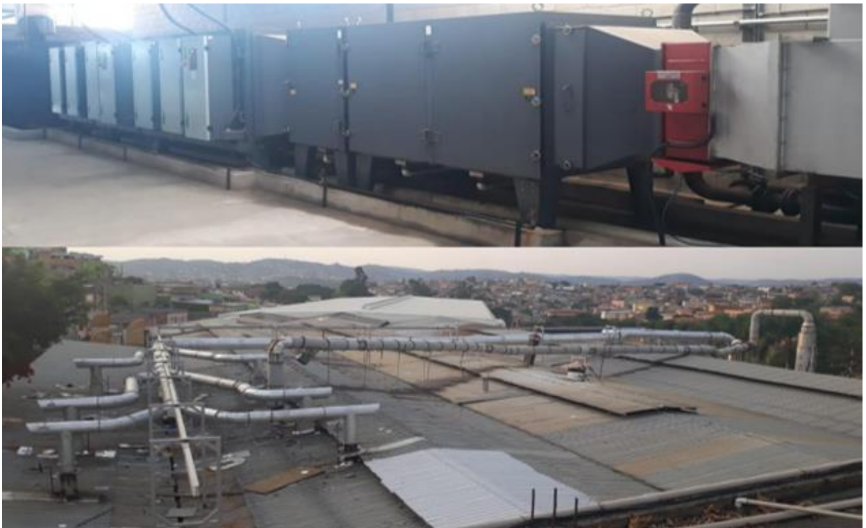
Figura 6.3.1: Filtro eletrostático e chaminés interligadas
