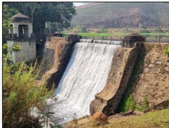
FOTO 02 – Barramento no ribeirão da Cachoeirinha.
