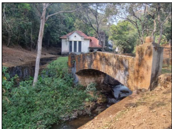
FOTO 05 – Casa de força com canal de fuga e TVR.
