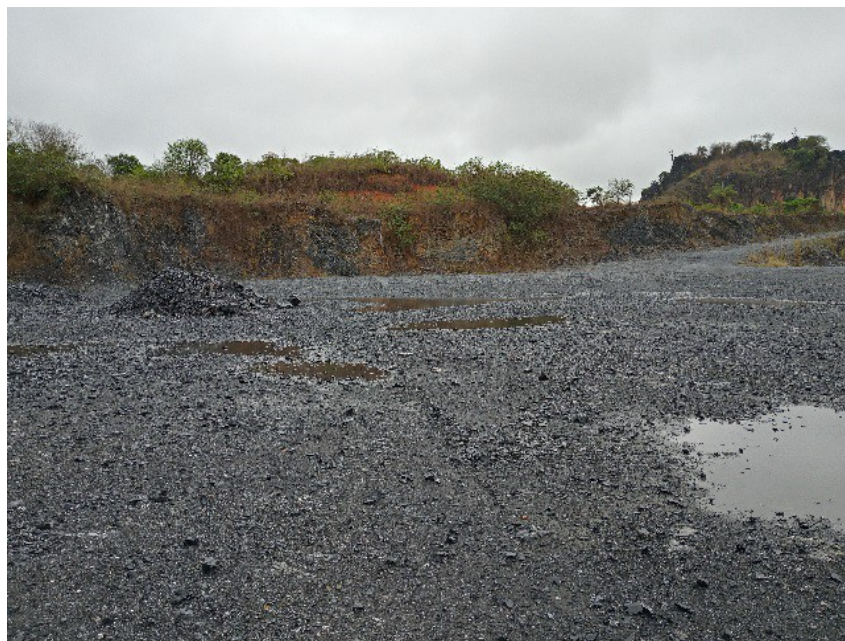
Outros pontos de acumulação de água na cava 01
