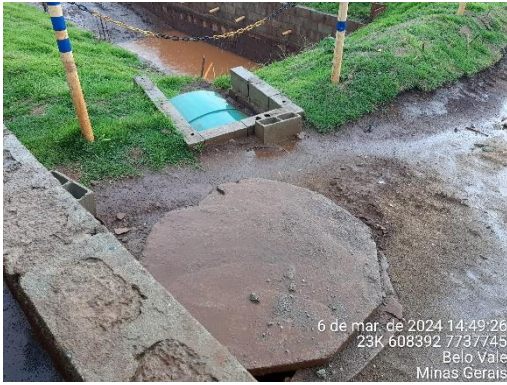
Foto 43: CSAO da oficina e lavador de veículos.
