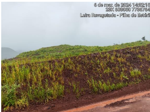
Foto 5: Pilha de estéril com implantação de atividade de revegetação nos taludes.
