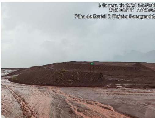
Foto 9: Pilha de Rejeito Desaguado que deverá ser reprocessado devido ao alto teor de minério existente no material empilhado.
