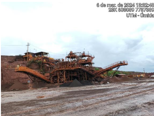
Foto 11: UTM a úmido em operação.
