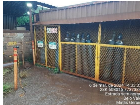
Foto 64: Local de armazenamento de gases.
