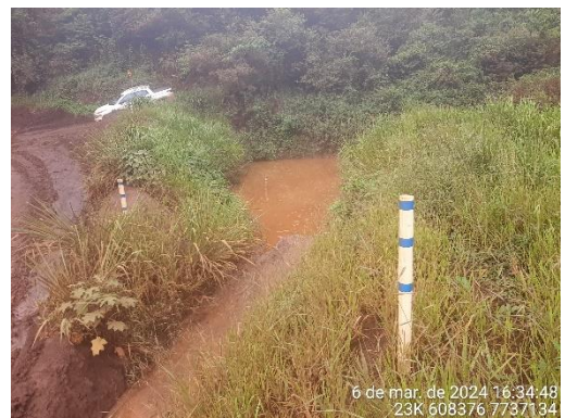
Foto 10: Sump na margem do acesso, no ponto de interceptação do Córrego das Flores.
