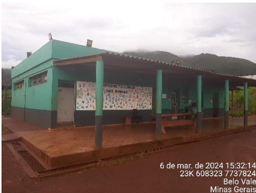
Foto 35: Refeitório e banheiros.
