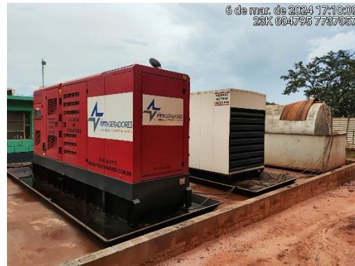
Foto 16: Geradores com bandejas coletoras. Na foto é possível verificar a estrutura de alvenaria de contenção.
