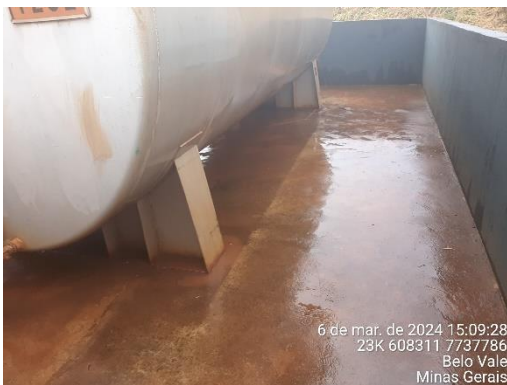
Foto 27: Detalhe do piso da caixa de contenção de alvenaria.
