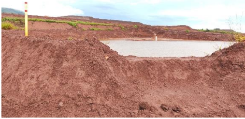
Foto 13: Baia (cava ou caixote) funcionando como reservatório de água de chuva.
