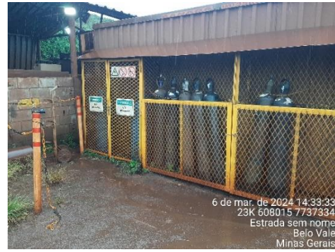
Foto 62: Local de armazenamento de gases.
