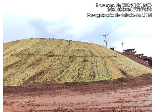
Foto 6: Talude sendo revegetado próximo a UTM.
