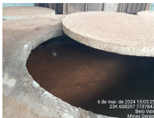
Foto 60: Sessão intermediária de separação da borra e efluente destinado ao sumidouro.
