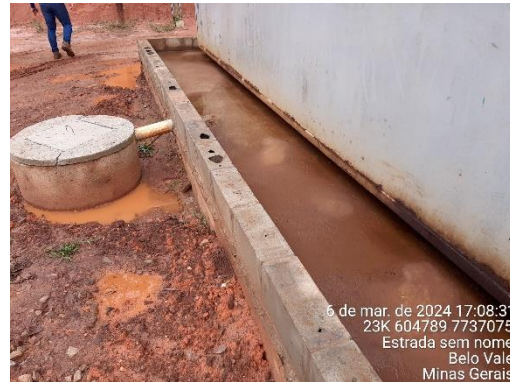
Foto 18: Caixa coletora de efluente ligada a estrutura de alvenaria impermeável de contenção.
