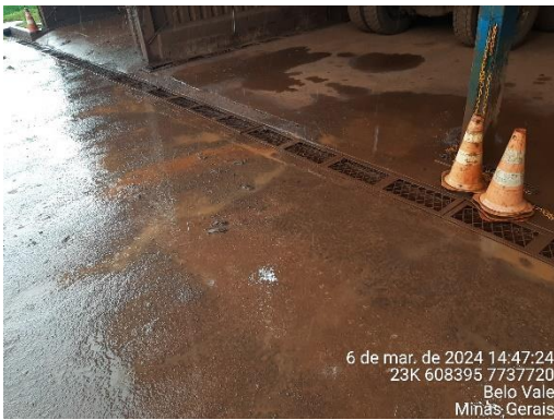
Foto 41: Canaletas coletoras de efluentes provenientes da oficina e lavador de veículos.
