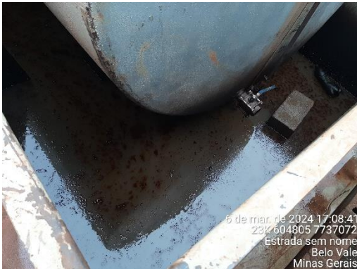
Foto 17: Borra de óleo com água dentro da contenção metálica do tanque de abastecimento de 15.000L.
