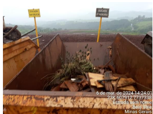
Foto 52: Caçamba de armazenamento de resíduos de madeira.
