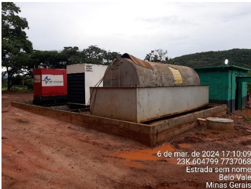
Foto 15: Geradores e tanque de combustível para funcionamento das bombas de captação e bombeamento da água da adutora.
