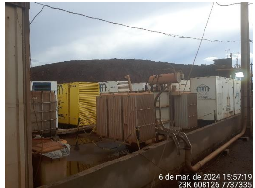
Foto 30: Estrutura de alvenaria impermeável com contida com muro.
