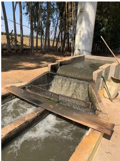
Foto 3. Segundo gradeamento
