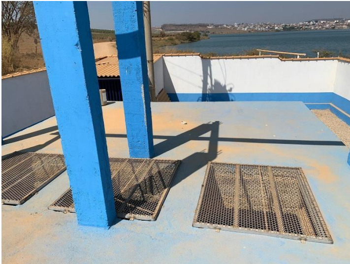
Foto 1. Recepção do efluente e elevatória
