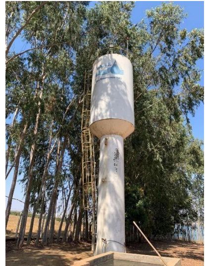
Foto 2. Reservatório de água potável
