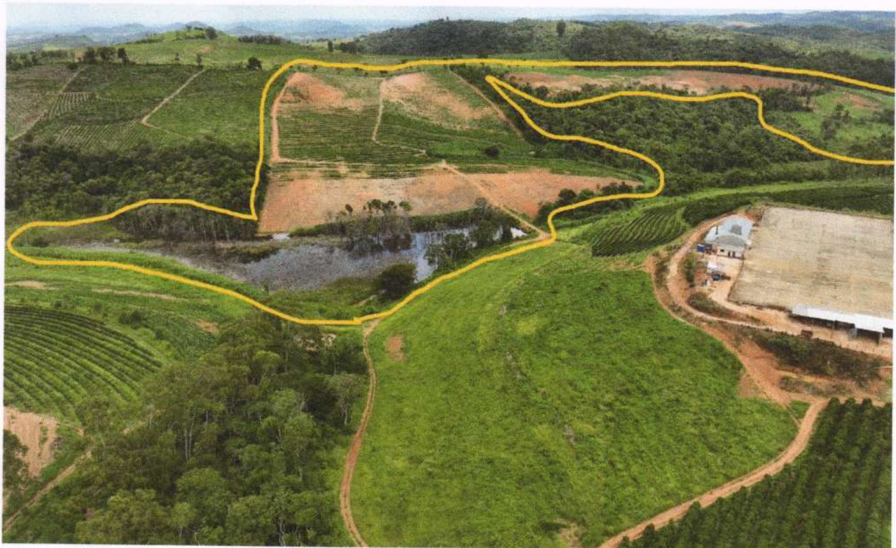
Áreas do imóvel onde ocorreram as intervenções delimitada pela linha amarela.
