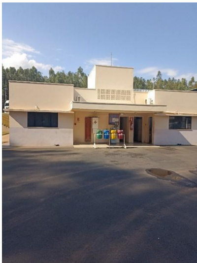
Foto 3. Estruturas de apoio e separação de resíduos
