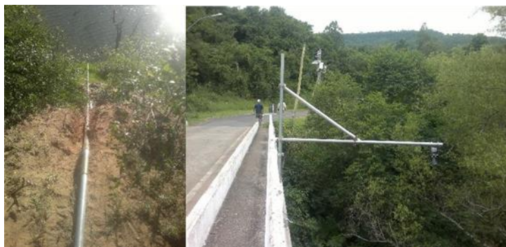
Figura 7: Tubulação de proteção do sensor de nível d'água: tipo transdutores de pressão, à esquerda (Estação Passo dos Farrapos, RS) e radar ultrassônico, à direita (Estação Picada Café, RS)
