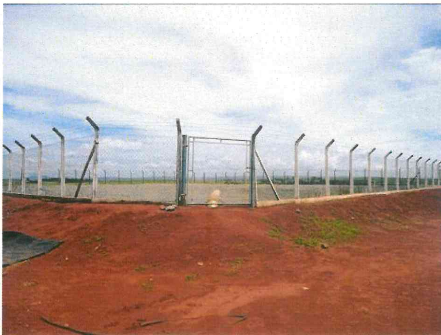
Reservatório de Vinhaça 02 – Fazenda Santa Clara (1002)
