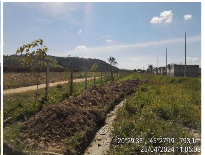
Foto 06. Limites do empreendimento
