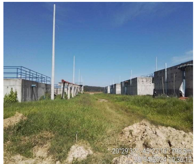
Foto 02. Reator RAFA e tanques de aeração
