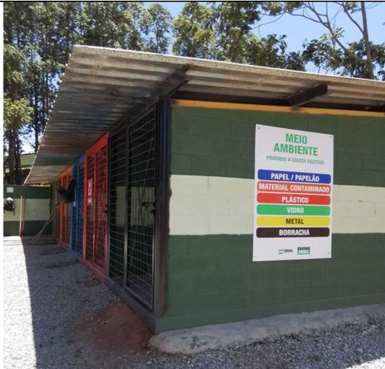
Foto 07. Armazenamento temporário de resíduos.
