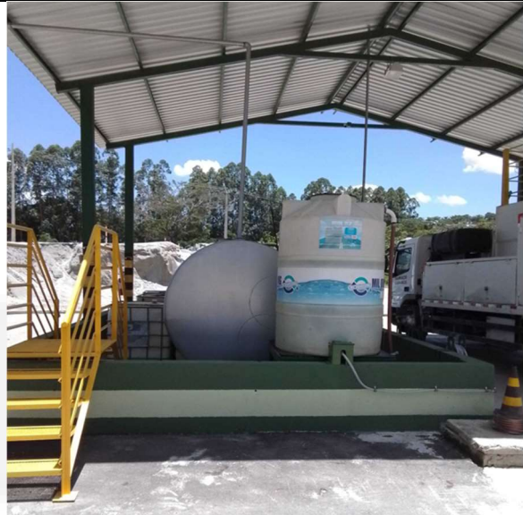
Foto 06. Área de abastecimento de veículos.
