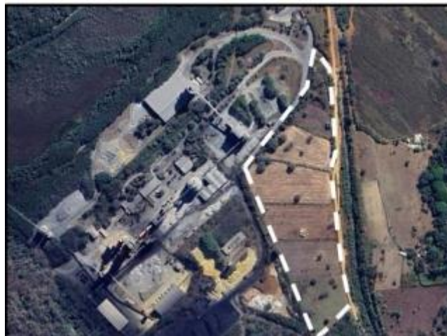
Figura 5 - Área prevista para instalação do novo pátio de insumos e galpão de aditivos
