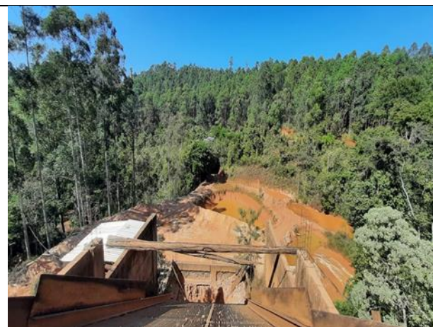
Figura 3-Visão das bacias de decantação.
