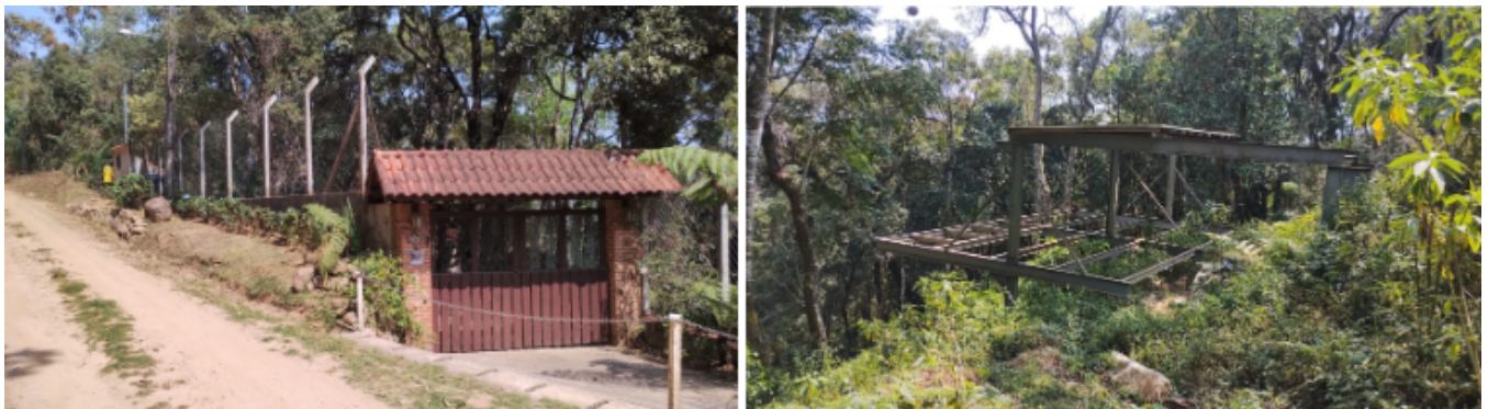
Figura 06: Caracterização da vizinhança lateral. Residência estabelecida e estrutura de residência inacabada.
