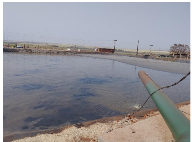
Foto 04. Lagoa de águas residuárias
