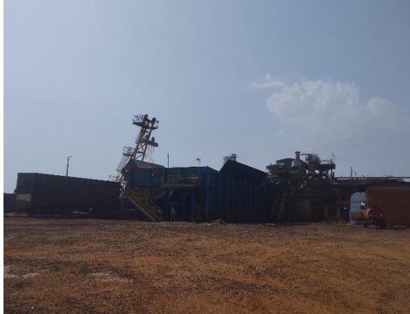
Foto 01. Vista da usina, setor de moagem.
