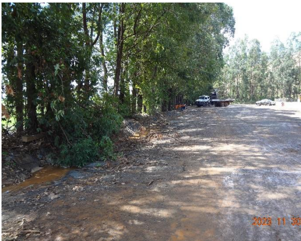
Foto 25 – Acesso em frente à oficina e local de abastecimento. Na porção esquerda da foto pode ser verificado que a condução da água pluvial é direcionada para as bacias de sedimentação.
