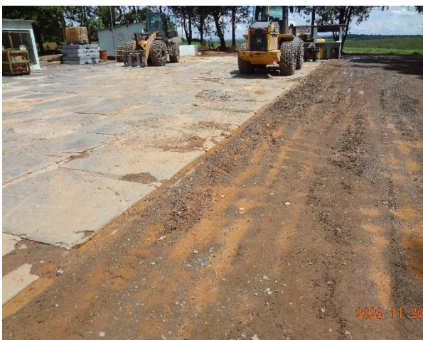
Foto 11 – Detalhe da canaleta no pátio da
