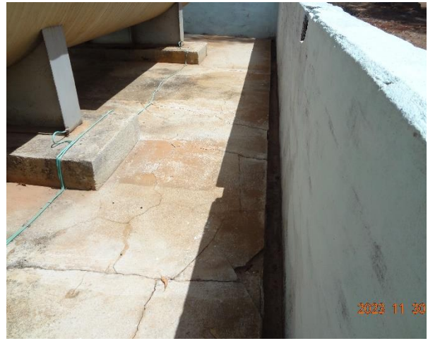
Foto 18 – Detalhe do piso na bacia de contenção apresentando algumas trincas na camada superficial do piso.
