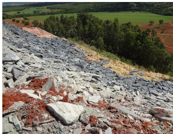
Foto 06– Berma estreita e descontínua com talude instável, na pilha de estéril da Minerar.
