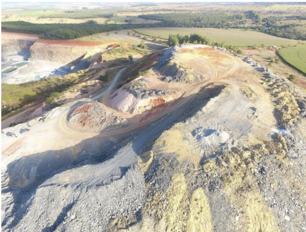
Figura 7. Vista geral da pilha de rejeitos do empreendimento.
