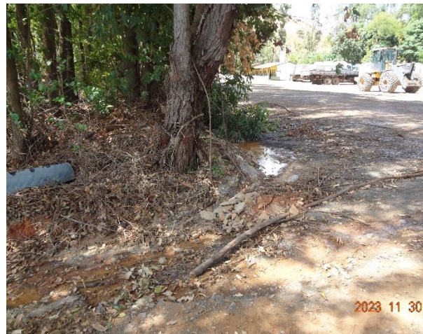
Foto 26 – Ponto com início de erosão onde a água pluvial é direcionada para as bacias de sedimentação.
