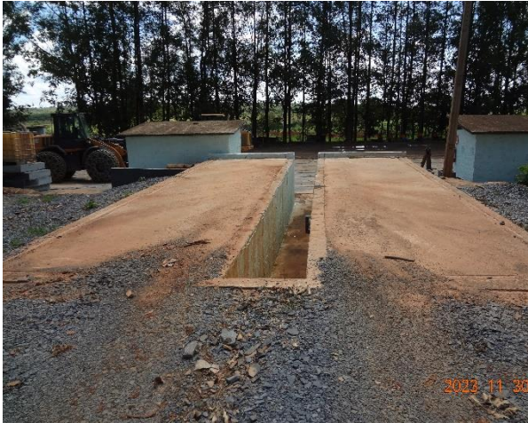
Foto 13 – Rampa de manutenção e troca de óleo ao lado da oficina.
