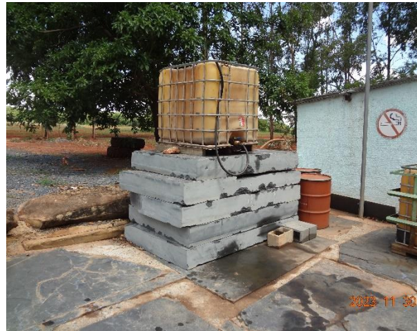
Foto 16 – Armazenamento e distribuição de combustível sendo realizado de forma inadequada.
