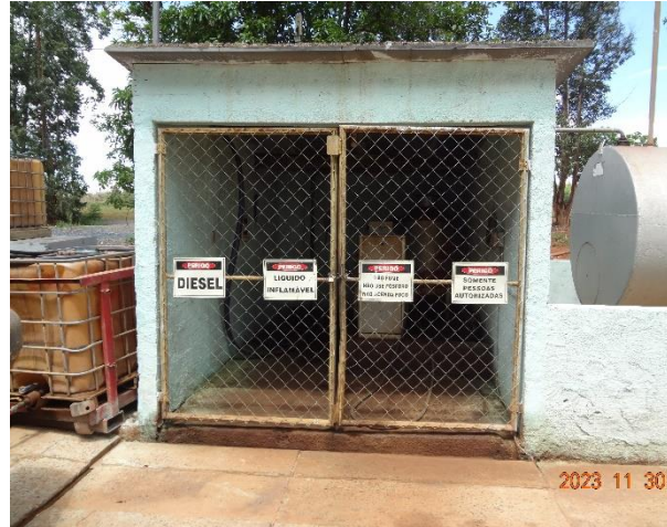
Foto 14 – Local de abastecimento de combustível.
