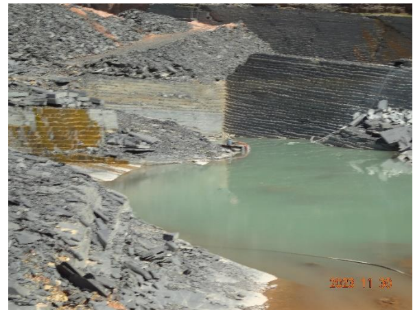
Foto 04 – Água represada no fundo da cava. Detalhe: ao fundo uma bomba utilizada para abastecer caminhões pipas.
