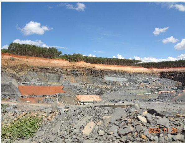
Foto 03 – Contenção definida como divisa do título minerário em relação ao título de terceiro.
