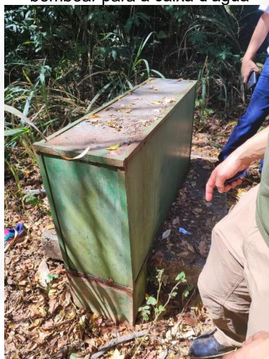
Poço encapsulado para prevenção de vândalos
