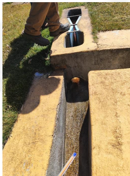
Medidor de vazão no ponto de lançamento
