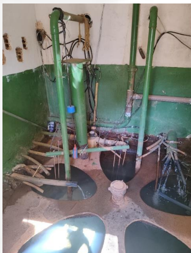
Interior do local de captação, onde a água é armazenada para bombear para a caixa d'água
