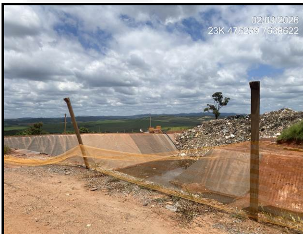
FOTO 3 – Aterro de resíduos Classe I com impermeabilização dos taludes.
