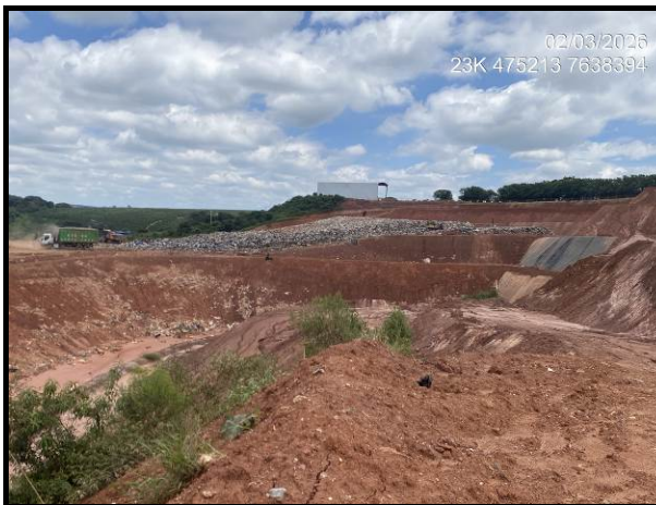
FOTO 1 – Aterro de resíduos Classe II com avanço na porção norte, correspondente a fase 3 de expansão.
