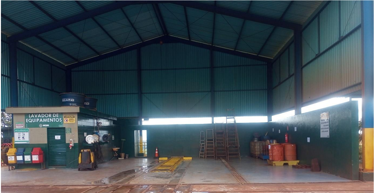
Figura 28: Vista do lavador de veículos. Fonte: Auto de Fiscalização nº 243153/2024.
