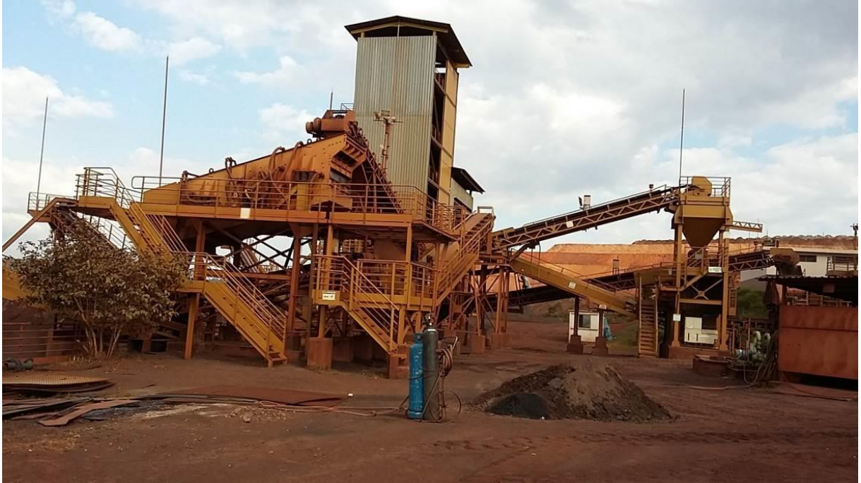
Figura 6: Vista da planta de beneficiamento. Fonte: EIA, pág.71, 2023.
