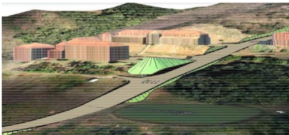
Imagem mostrando, de lado, a rampa de escape ou invertida, para a eventual problema no sistema de frenagem do caminhão.
