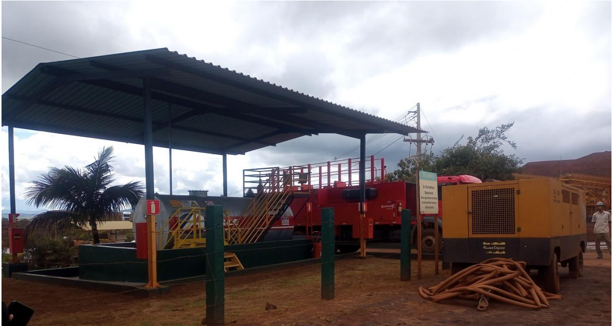
Figura 26: Vista do posto de abastecimento.
