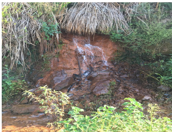
Figura 4: Afloramento de água no corpo 03 (parede nordeste da cava).
