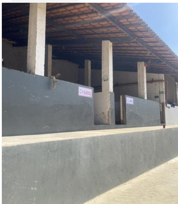
Foto 03. Galpão de armazenamento temporário de resíduos sólidos
