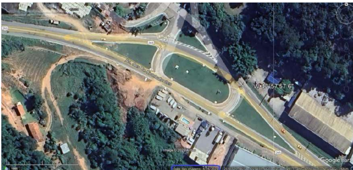
Figura 9 - Erosão do Córrego da Coruja em 24/04/2024. FONTE: Google Earth Pro.
