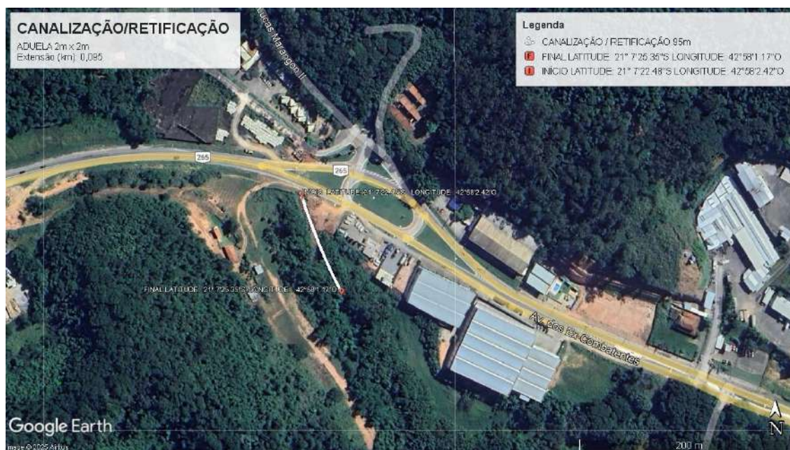
Figura 01 - Canalização/Retificação de Trecho do Córrego da Coruja (95m)
