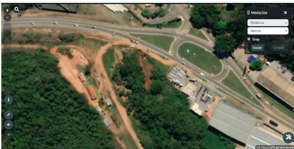
Figura 8 - Erosão do Córrego da Coruja. FONTE: GEO UBÁ. Acesso em: MAR. 2025.
