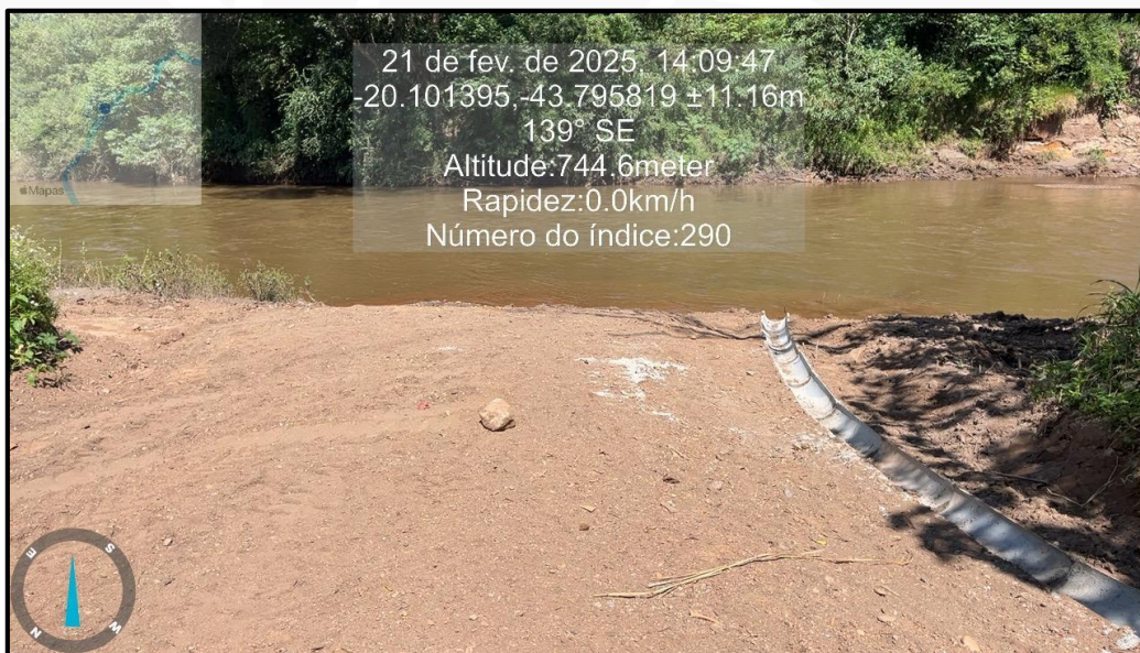
Figuras 07 e 08: Andamento das obras de drenagem pluvial
