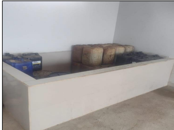
Figura 17: Depósito de Resíduos Perigosos sobre bacia de contenção
