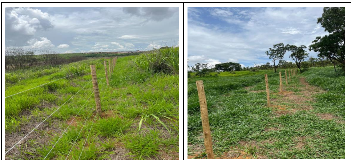
Registro fotográfico fiscalização do Produto 1- Fornecimento de material e mão de obra para execução do cercamento de todas as propriedades participantes.
