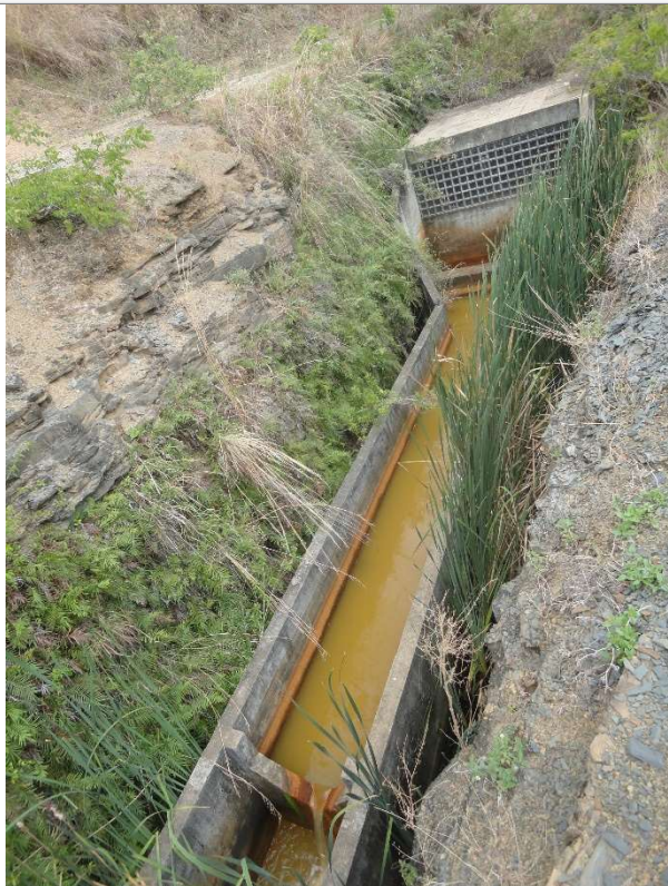
Figura 04 – Fotos do sistema de descarga de fundo e registro.
