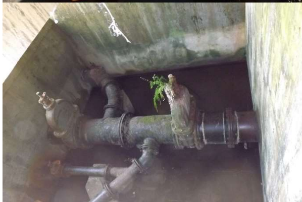
Figura 04 – Fotos do sistema de descarga de fundo e registro.
