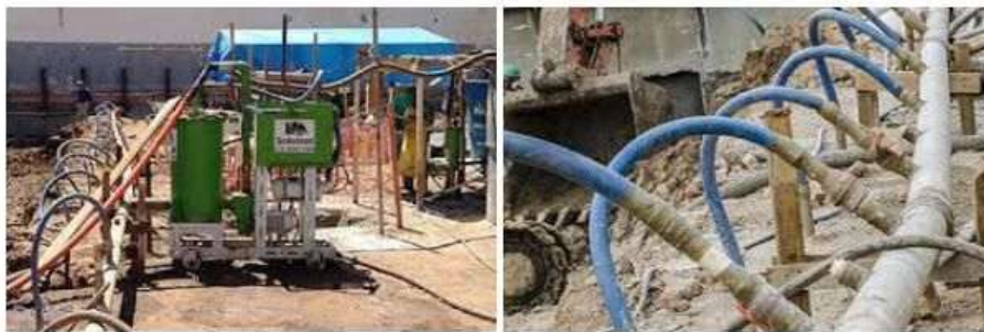
Fig. 2: Exemplo de Sistema de Rebaixamento por Ponteiros Filtrantes a Vácuo
