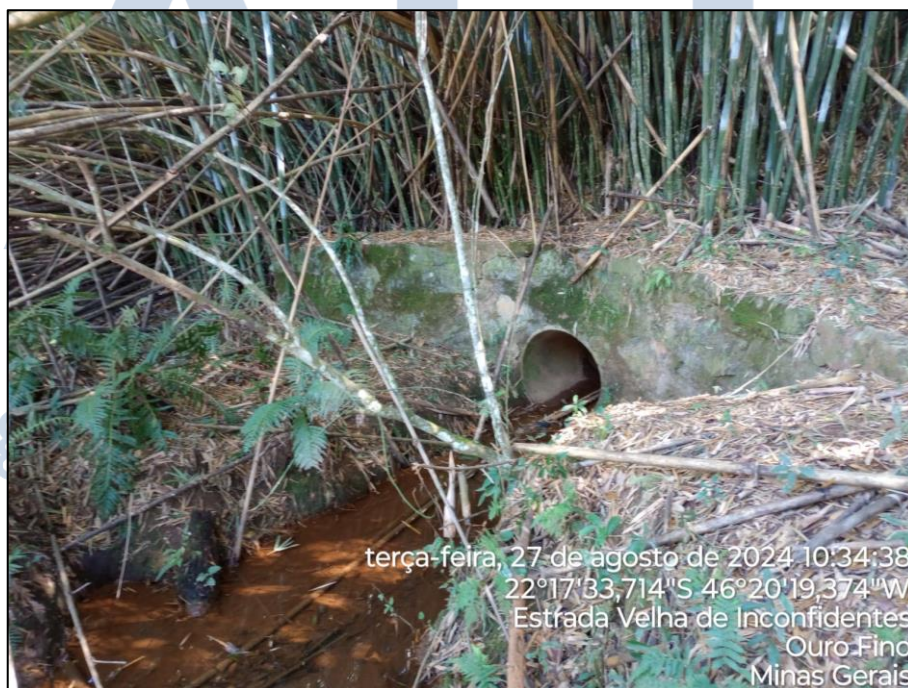
Imagem 05 – Início da Intervenção.
