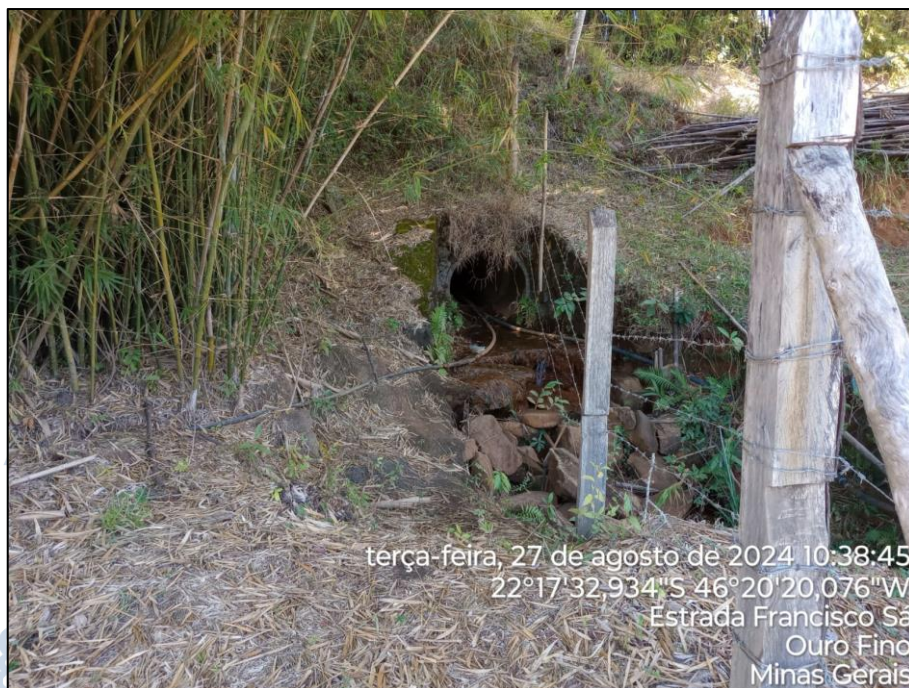
Imagem 13 – Fim da Intervenção.
