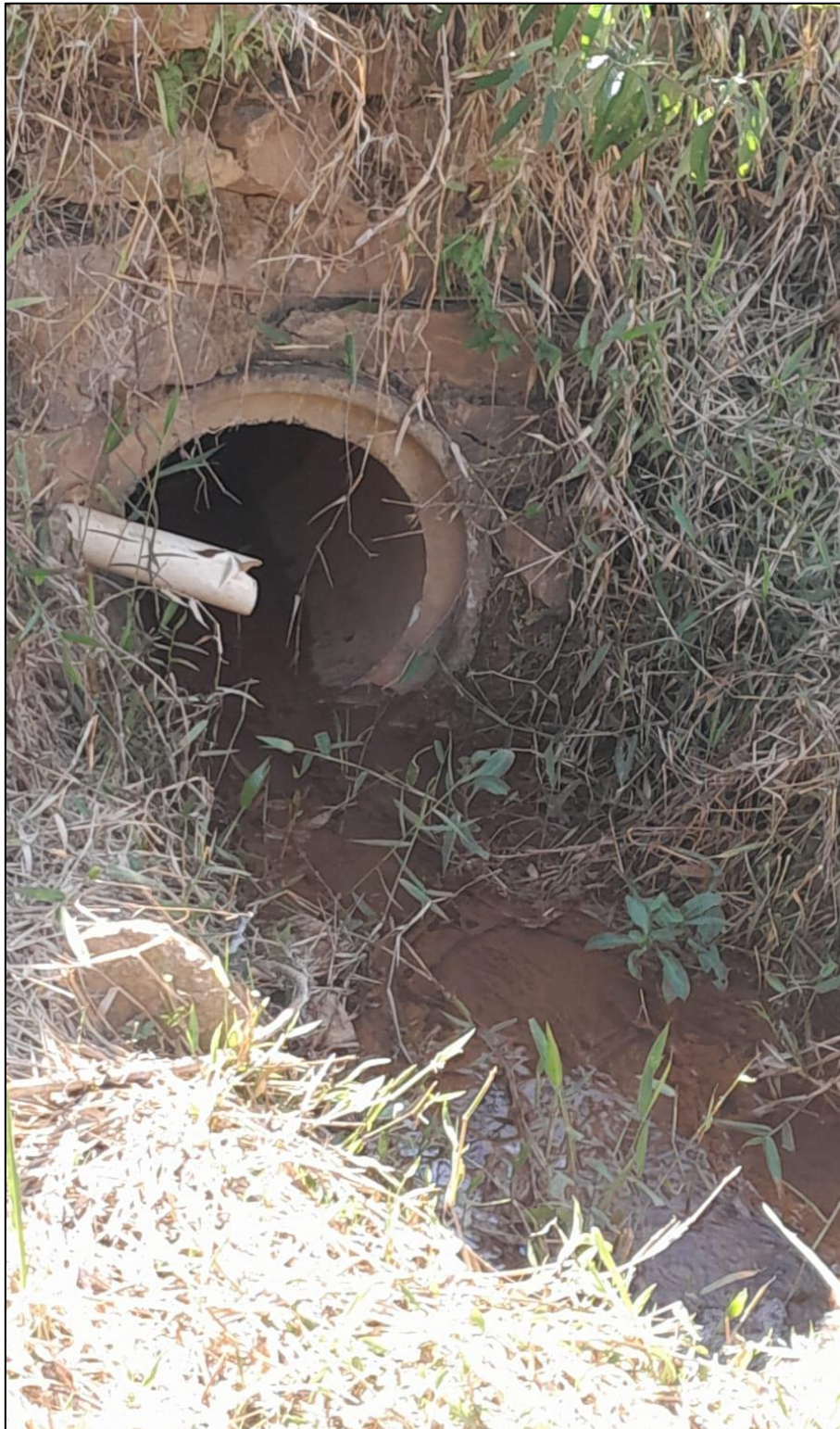
Figura 07 – Manilha de 700 mm do trecho já canalizado.
