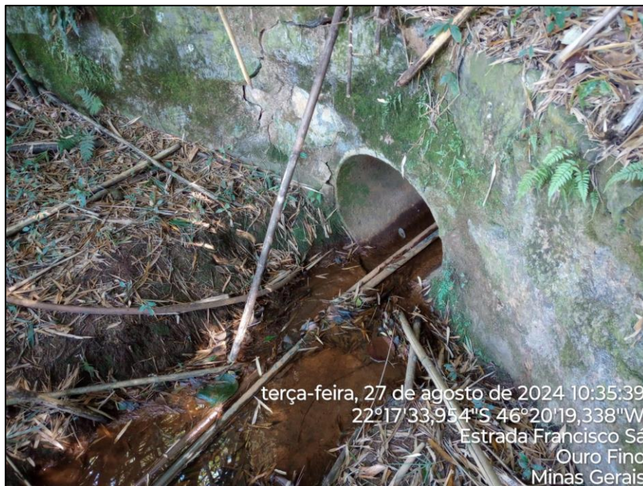
Imagem 04 – Início da Intervenção.
