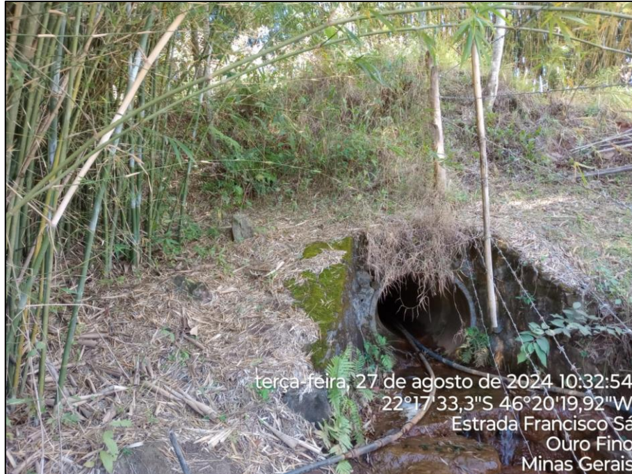
Imagem 12 – Fim da Intervenção.
