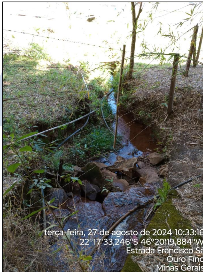
Imagem 11 – Fim da Intervenção.
