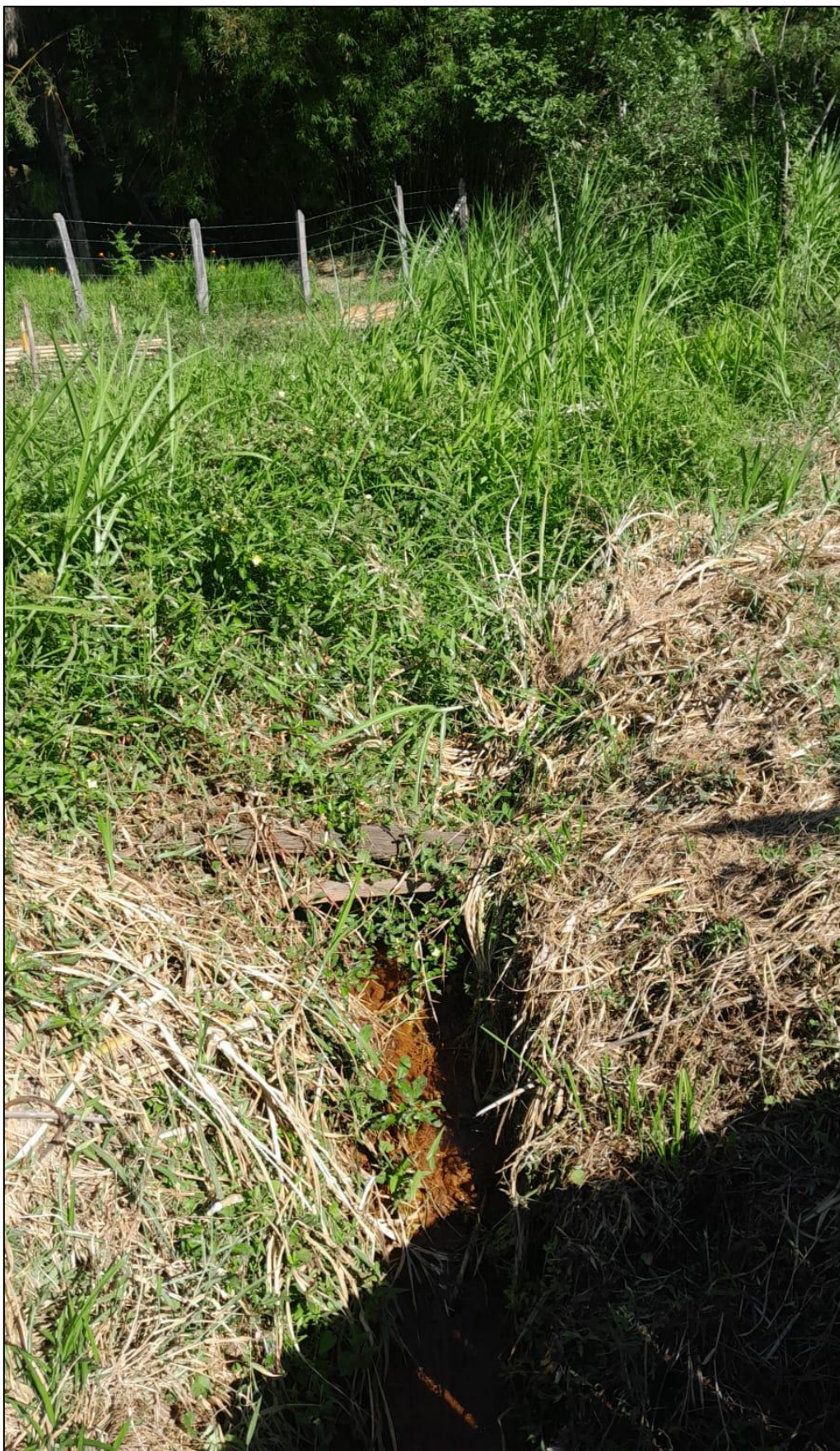
Figura 06 – Trecho natural a ser canalizado.
