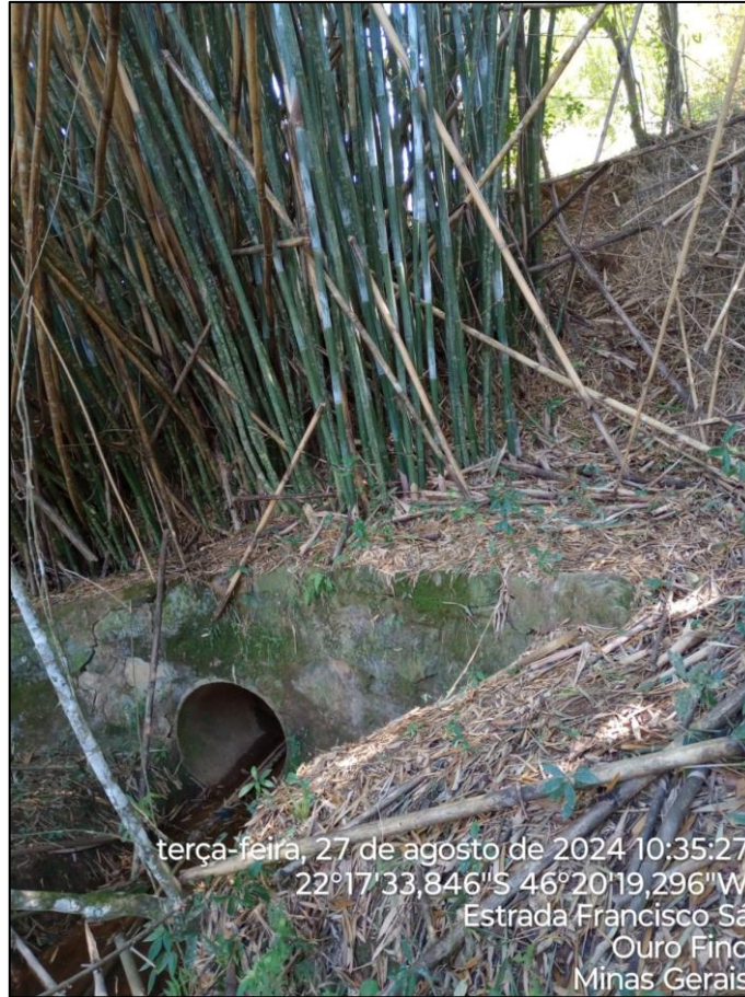
Imagem 06 – Início da Intervenção.
