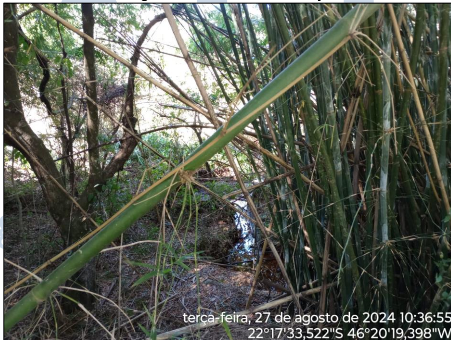
Imagem 07 – Início da Intervenção.
