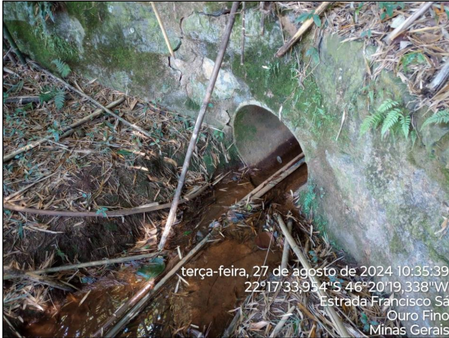
Imagem 08 – Início da Intervenção.
