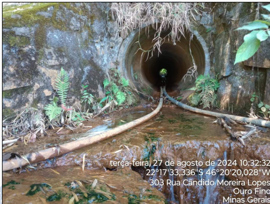
Imagem 15 – Fim da Intervenção.
