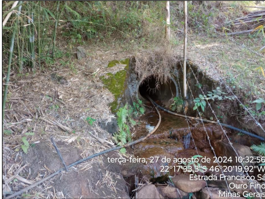
Imagem 14 – Fim da Intervenção.
