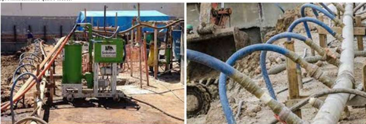
Figura 5. Exemplo de Sistema de Rebaixamento por Ponteiros Filtrantes a Vácuo. Fonte: Estudo apresentado.
