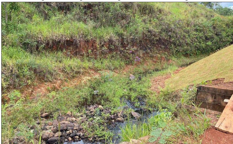
Figura 21 – Região de deságue do canal de drenagem.
