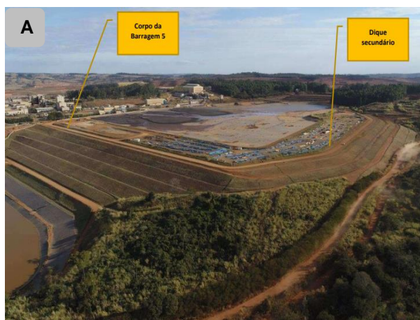
A) Vista ampla da Barragem 5
