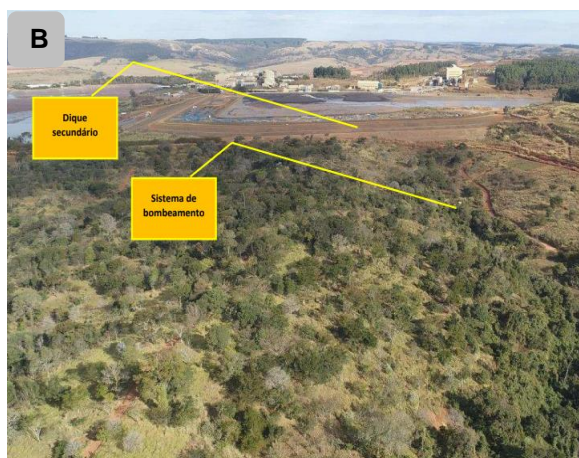
B) Dique Lateral da Barragem 5 e local onde ocorre o bombeamento do seu dreno
