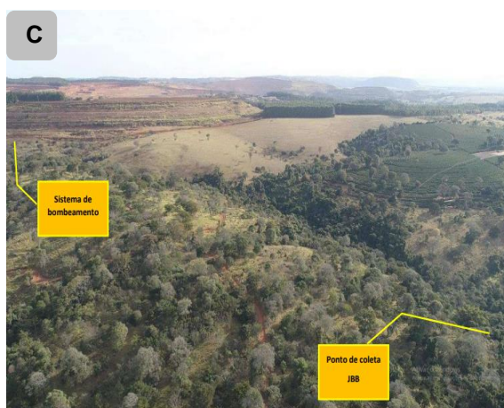
C) Cabeceira do córrego Feio em vista de jusante para montante, podendo-se observar o local do sistema de bombeamento e o ponto de monitoramento JBB
