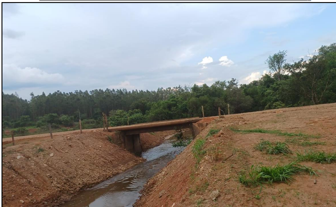
Figura 3: Ponte de concreto sobre o Ribeirão da Antinha.
