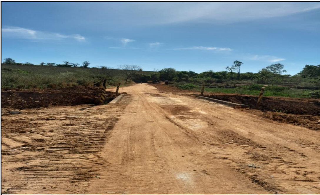
Figura 2: Ponte de concreto sobre o Ribeirão da Antinha.
