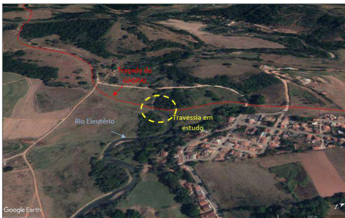
Figura 1 – Visão geral do entorno da travessia do GASPAJ no Rio Eleutério. Fonte: Google Earth.
