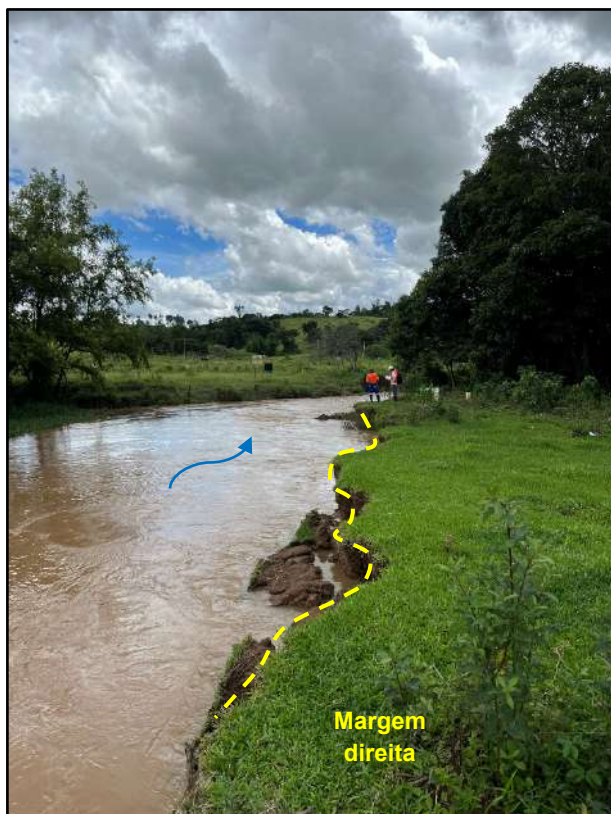
Figura 12 – Visada E-O da margem direita, com destaque para feições erosivas na região da travessia.
