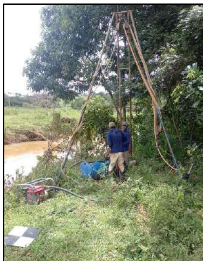
Figura 26 - Execução da sondagem SP-02 (Fonte: MCG Engenharia - RL-4710.04-6521-114-M9C-001).
