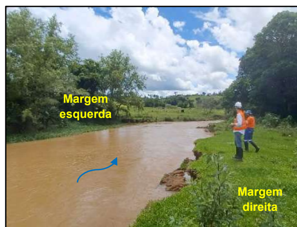
Figura 9 – Visada da travessia sob o Rio Eleutério, a partir da margem direita.
