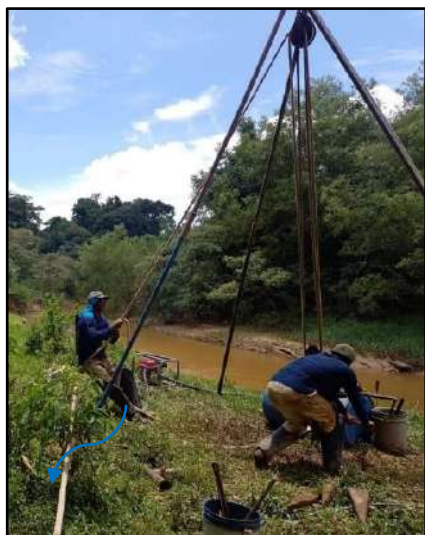
Figura 25 – Execução da sondagem SP-01 (Fonte: MCG Engenharia - RL-4710.04-6521-114-M9C-001).
