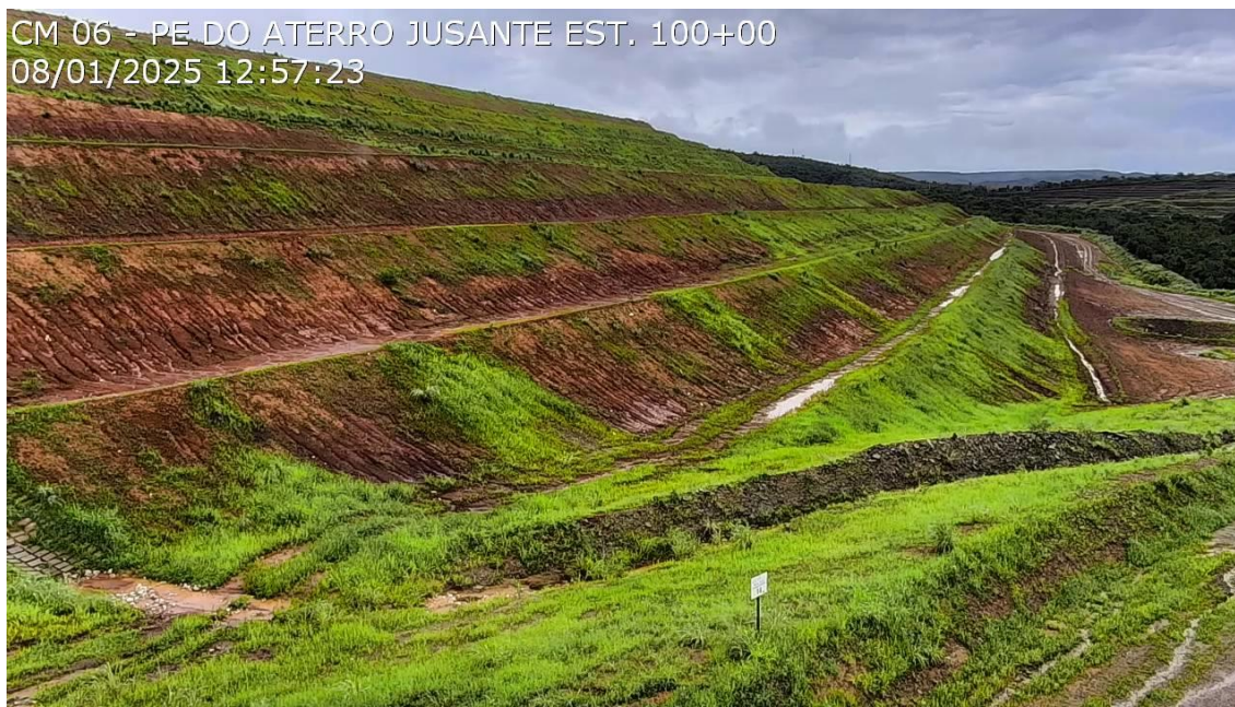
Figura 4 - Vista taludes e pé da Barragem Santo Antônio
