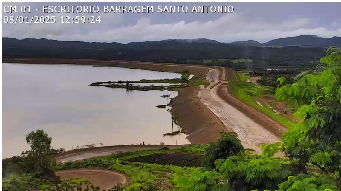
Figura 3 - Vista região reservatório Barragem Santo Antônio
