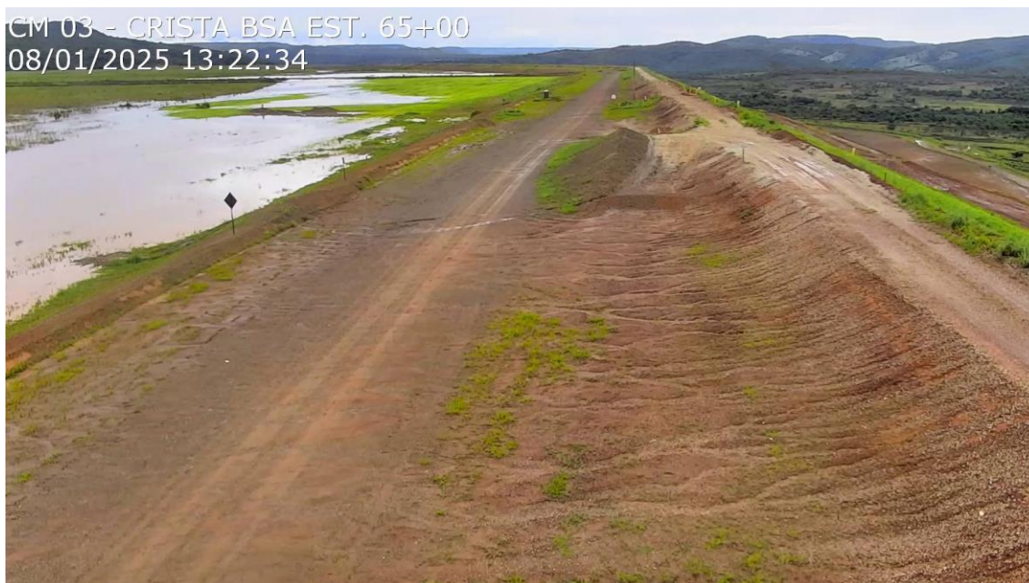
Figura 5 - Vista região da crista da Barragem Santo Antônio
