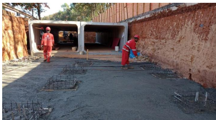
Figura 3 – Imagens das galerias de concreto com dimensões 4x3 m
