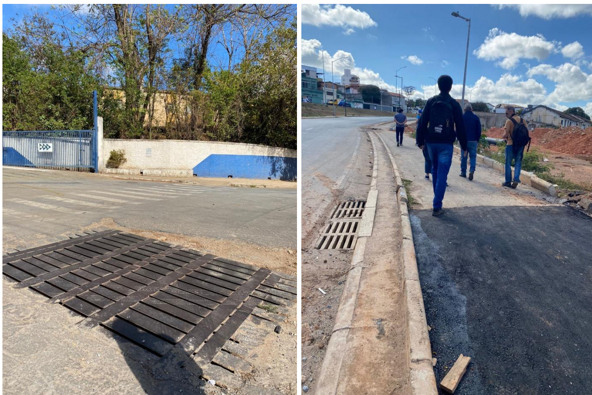
Figura 6 – Início da canalização do Córrego Santa Inês
