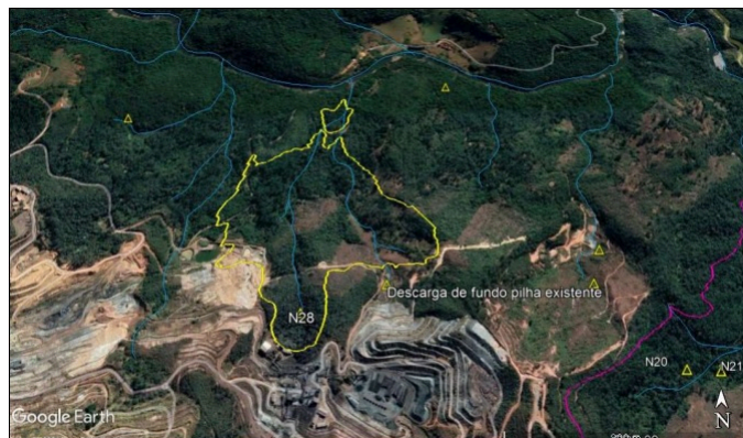
Figura 1: Visão geral da do local de futura implantação da PDE-11 e seu Sistema de Drenagem Interna (Drenos de Fundo DF-11.01 e DF-11.02).
