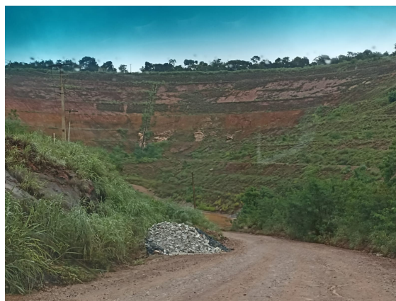
Vista da antiga cava do Extremo Norte em processo de recuperação dos taludes.
