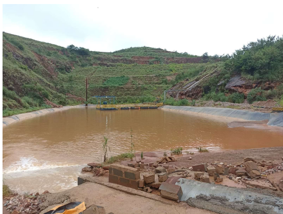
Tanque de armazenamento de água após a decantação recebendo também água pluvial das encostas da cava. Ao fundo observa-se o bombeamento e a tubulação de adução na porção direita da cava, para deságue no córrego Ouro Podre.
