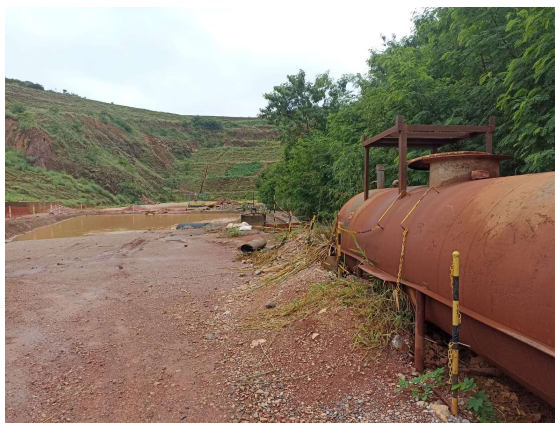
Detalhe da área (nível 615). À direita o tanque de flocculante e ao fundo as bacias de decantação/acumulação.
