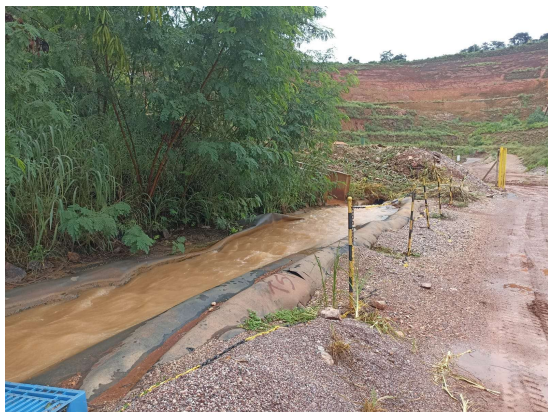
Canal de adução. Ao fundo a saída de água bombeada do nível 522.
