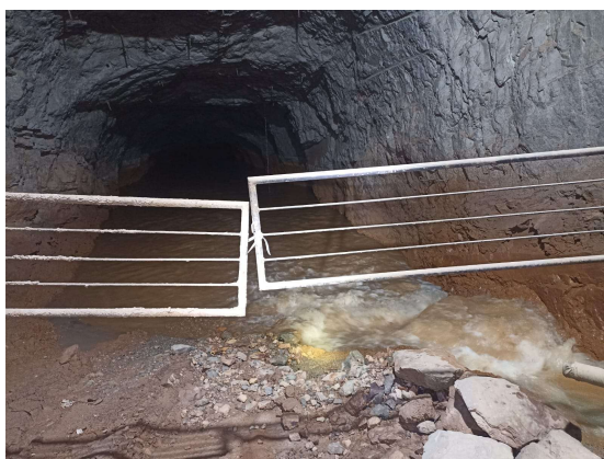
Detalhe da galeria que recebe o aporte de água. À direita observa-se a tubulação que passa por baixo da estrada de acesso.
