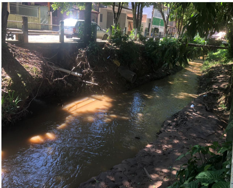
Figura 3 – Trecho do Córrego São José (2)
