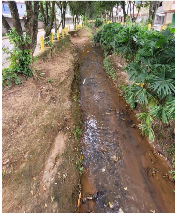
Figura 4 - Trecho do Córrego São José (3)
