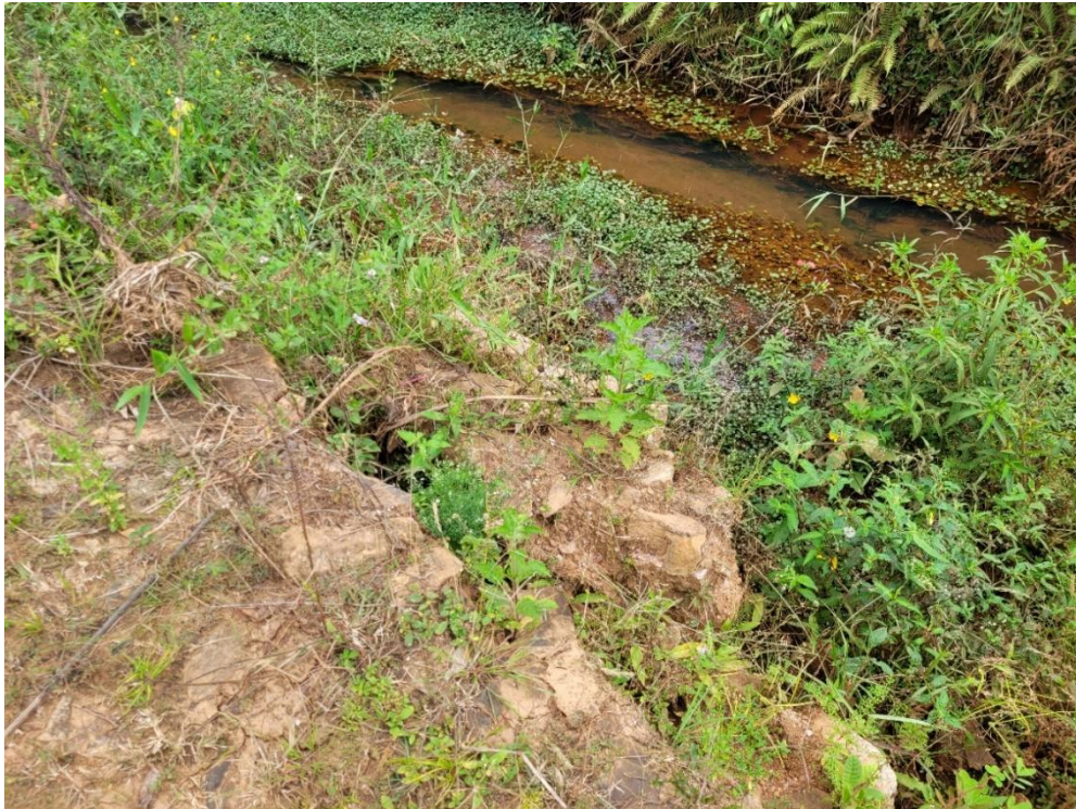
Registro Fotográfico 2: Ponto crítico no curso d'água do trecho a ser canalizado. Em 03/04/2023
