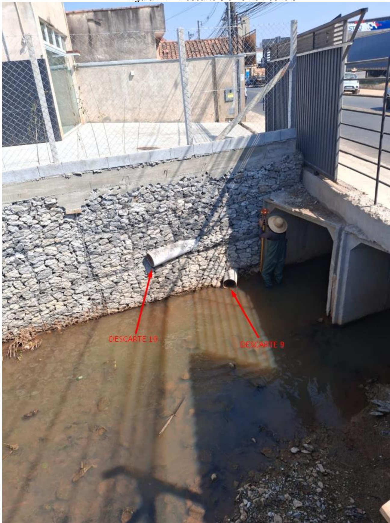
Figura 22 – Descarte 9 e 10 no trecho 3
