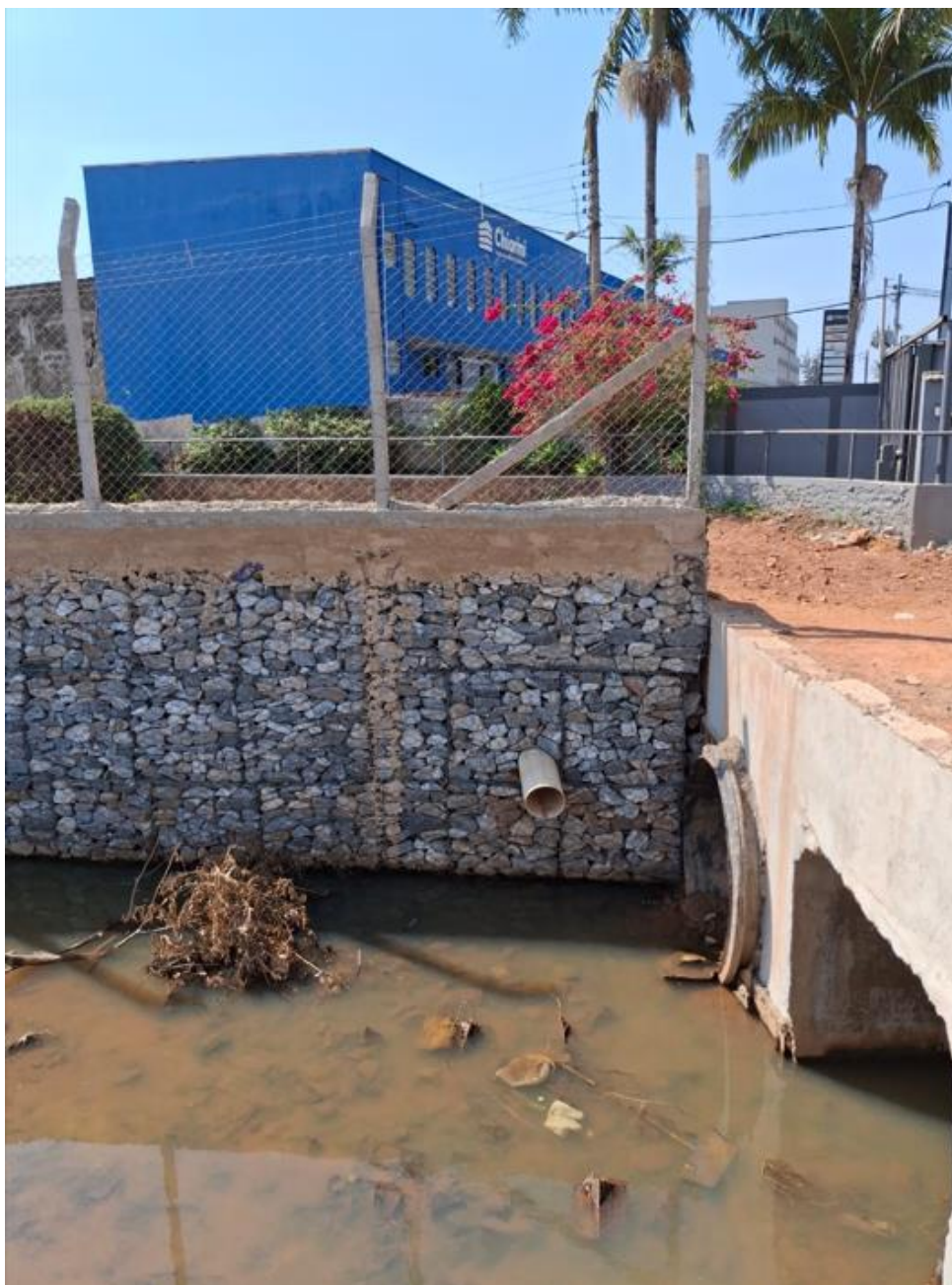
Figura 11 – Descarte 4 PVC DN 300 mm
