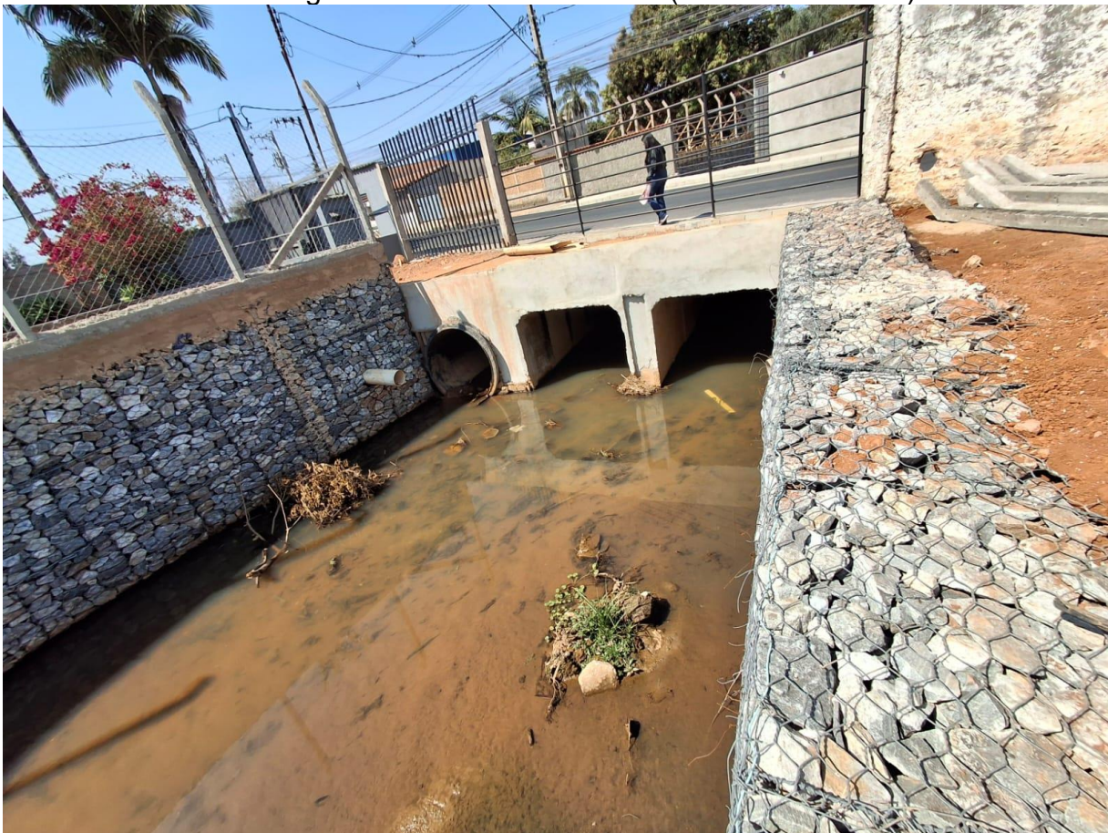
Figura 13 – Início do trecho 2 (entrada do bueiro)
