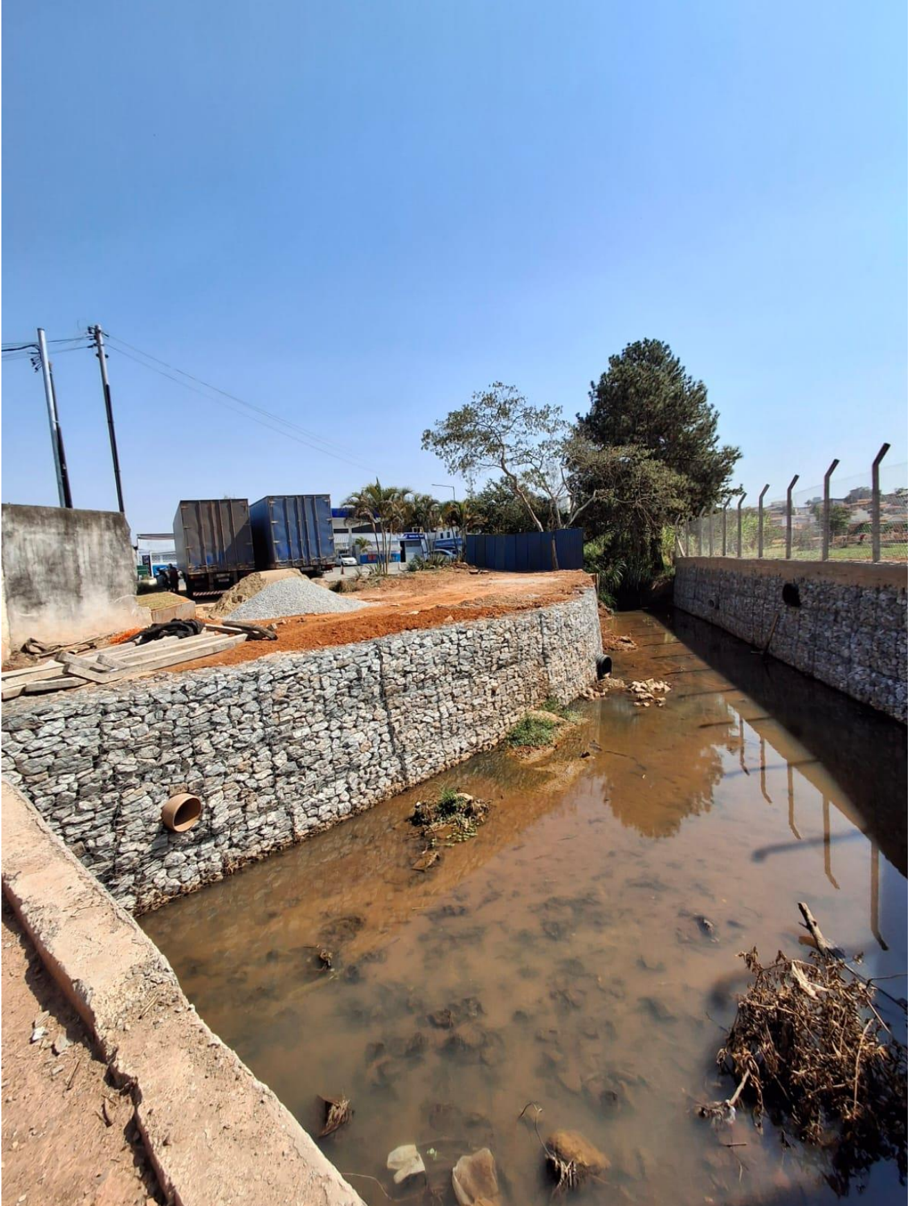
Figura 2 – Margem direita do trecho 1
