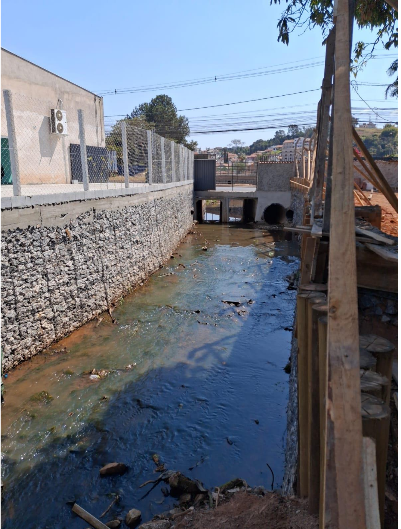
Figura 16 – Margem direita do trecho 3
