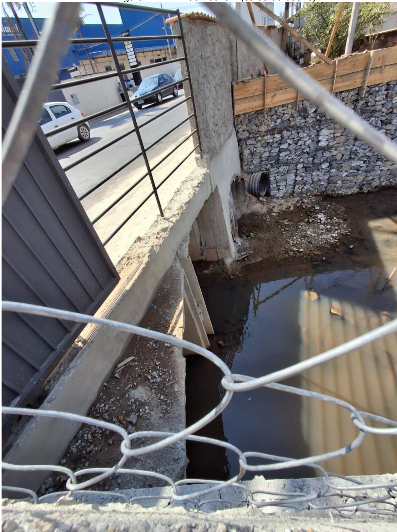
Figura 14 – Fim do trecho 2 (saída do bueiro)
