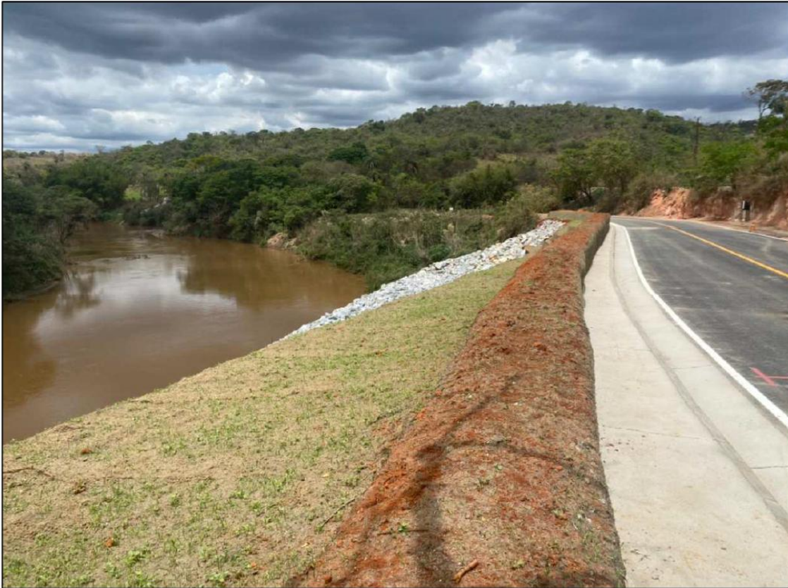
Figura 8 - Trecho após a obra
