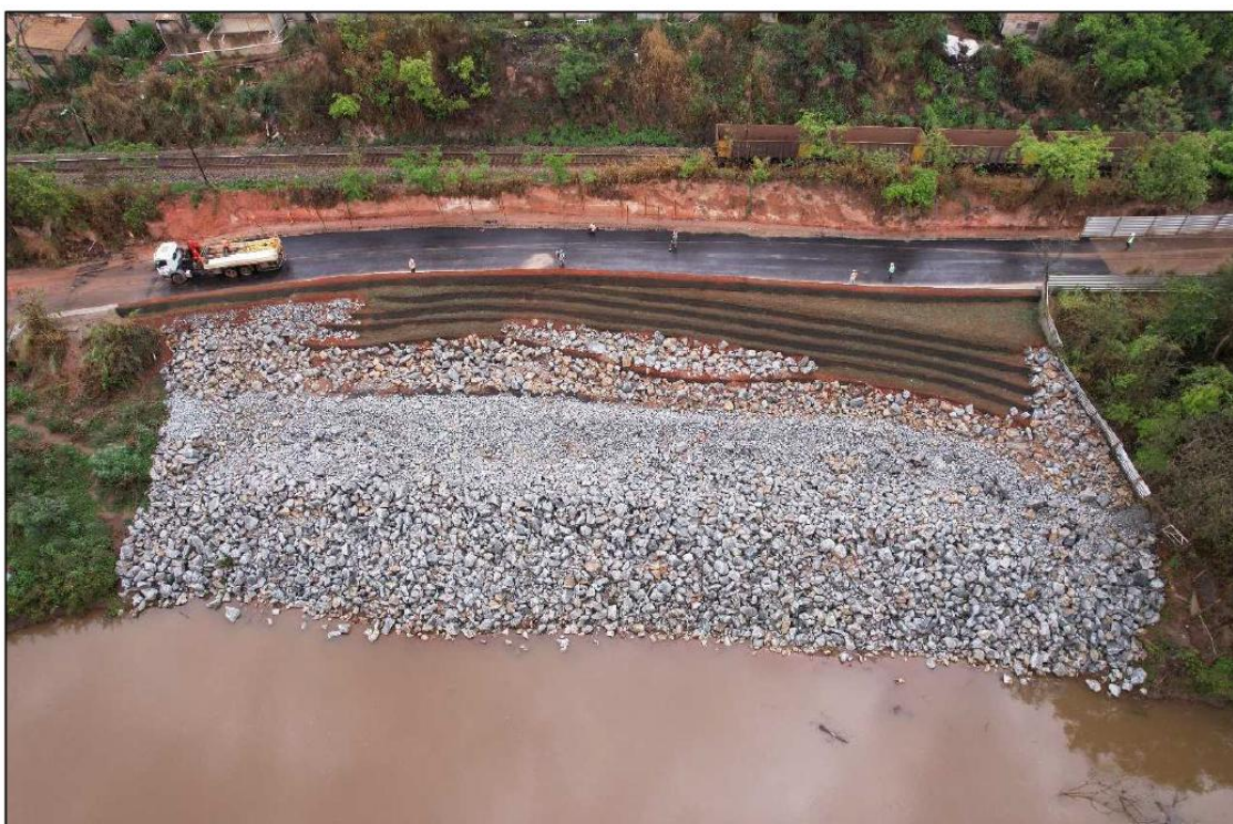
Figura 7 – Trecho em fase final das obras
