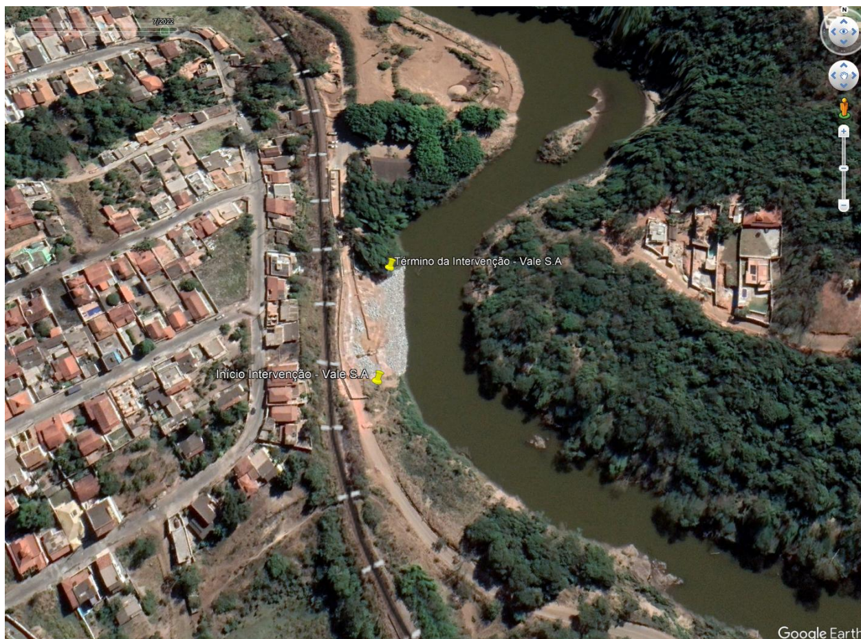
Figura 6 – Imagem da intervenção realizada na margem esquerda do Rio Paraopeba.
