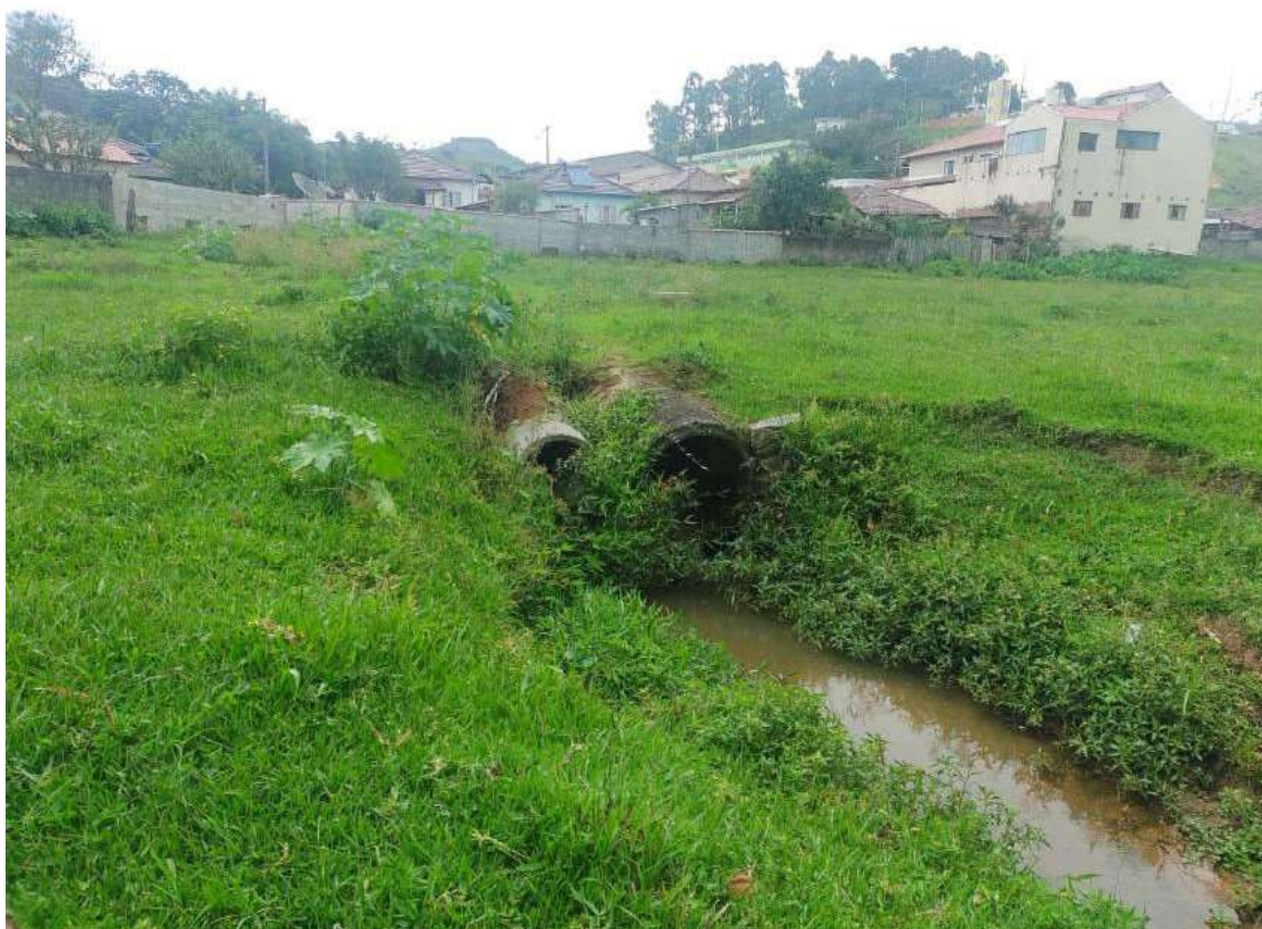
Figura 7 – Saída da canalização (AUTOR – 2014)
