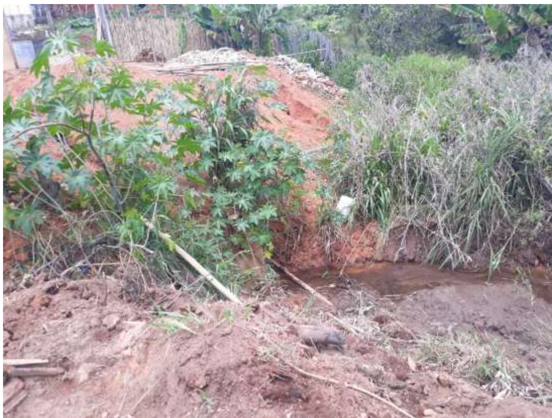
Figura 4: Imagem do início da canalização. Foto 20-10-2022
