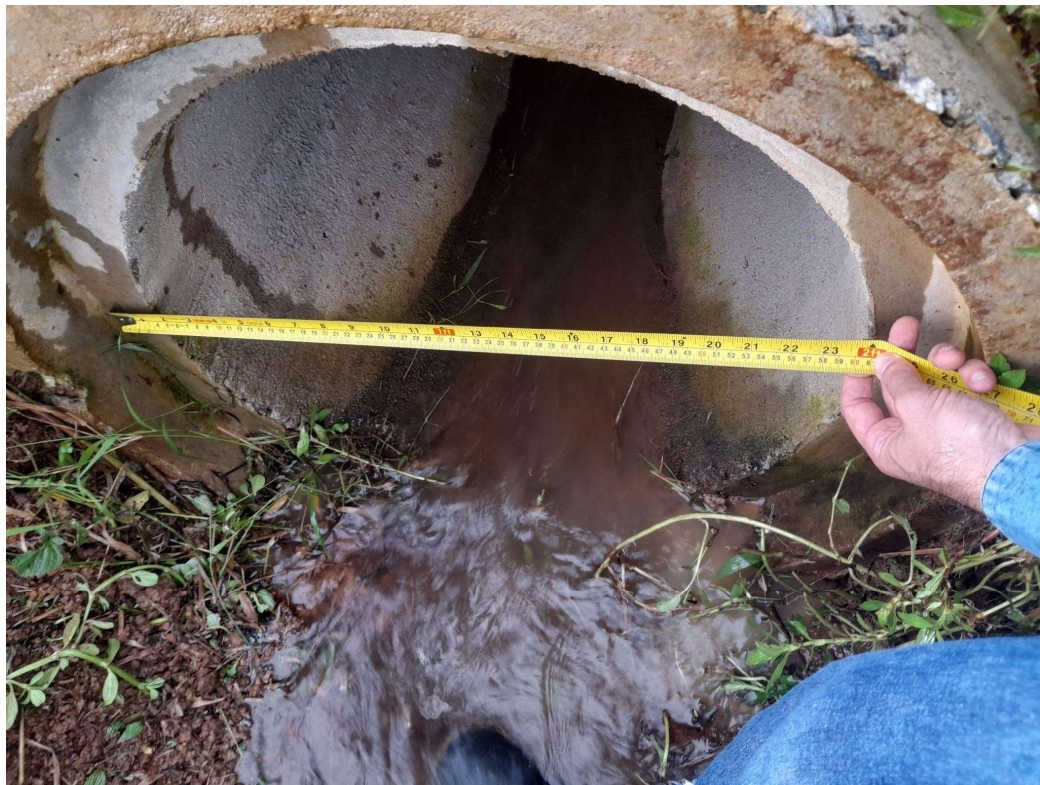
FIGURA – 24: AFERIMENTO DA TUBULAÇÃO INSTALADA (0,6 [m])
