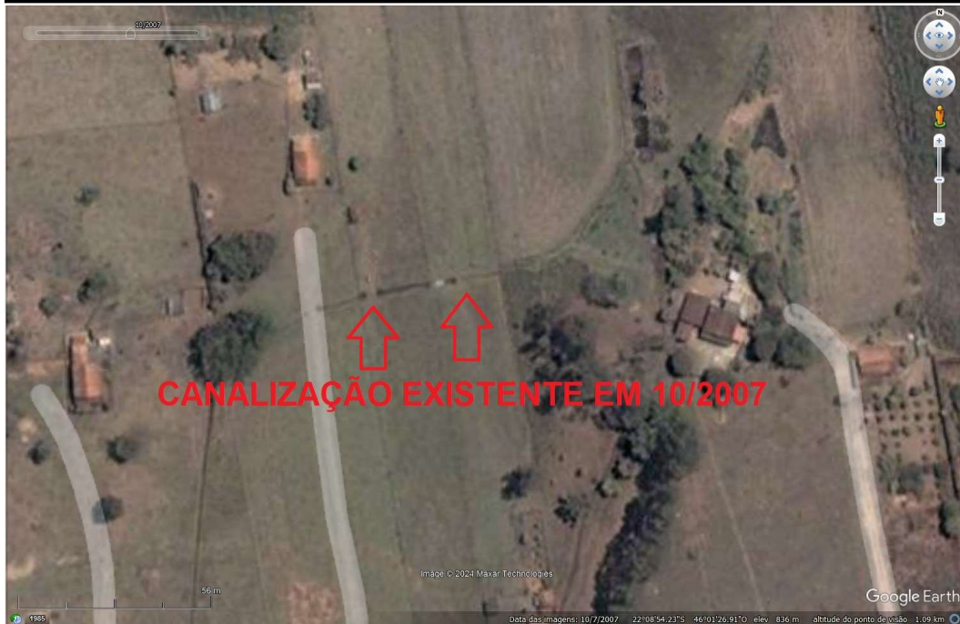
FIGURA – 13: CANALIZAÇÃO EXISTENTE EM 10/2007
