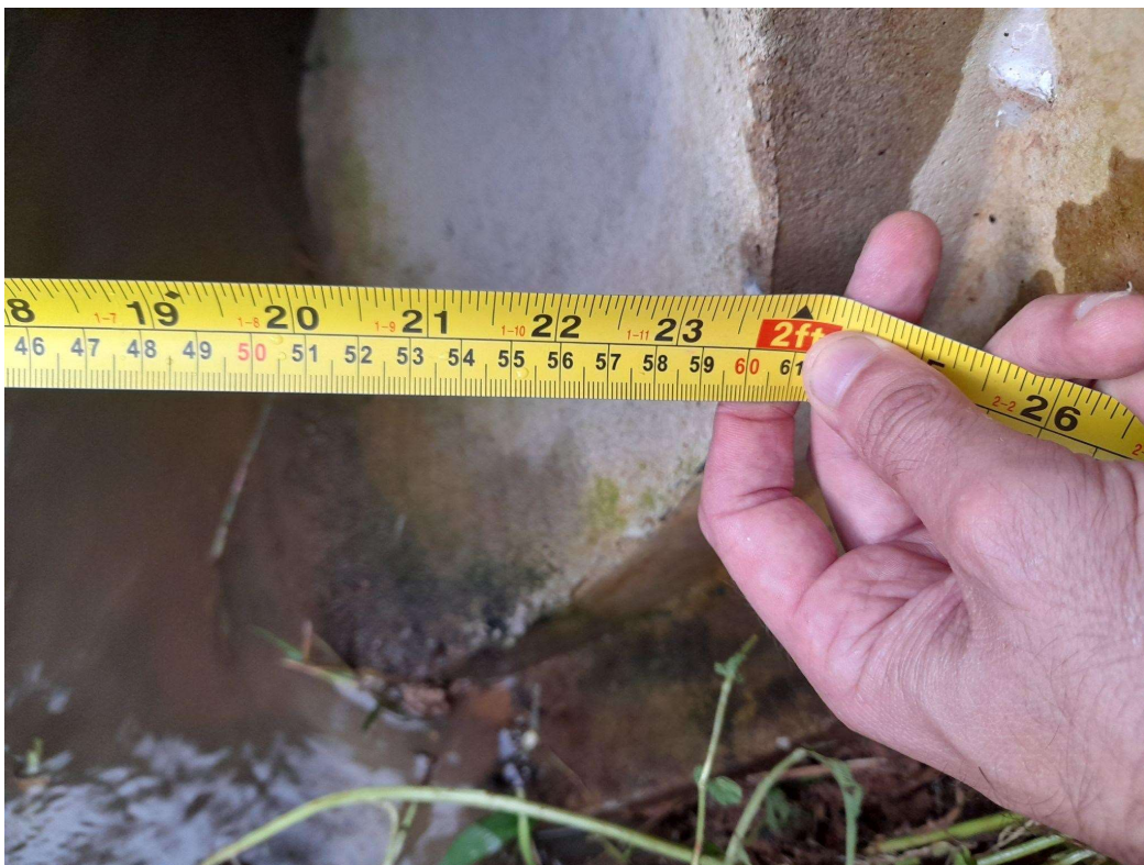
FIGURA – 25: DETALHE DA TUBULAÇÃO INSTALADA (60 [cm])
