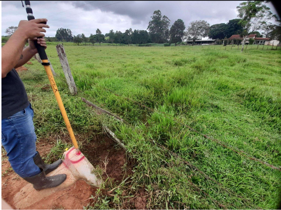
FIGURA – 20: COLETA DE DADOS TOPOGRÁFICOS / INÍCIO DA CANALIZAÇÃO ATUAL (MONTANTE)
